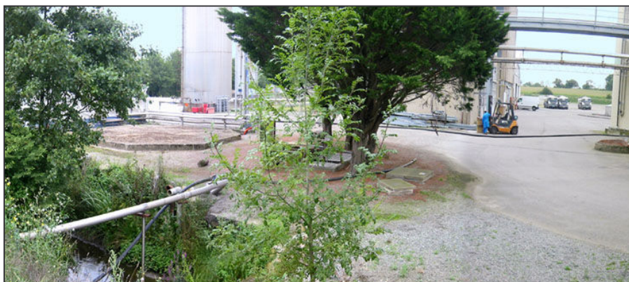
Le lit mineur du Boivre longeant le remblai de l'usine de la Laiterie Saint-Père
