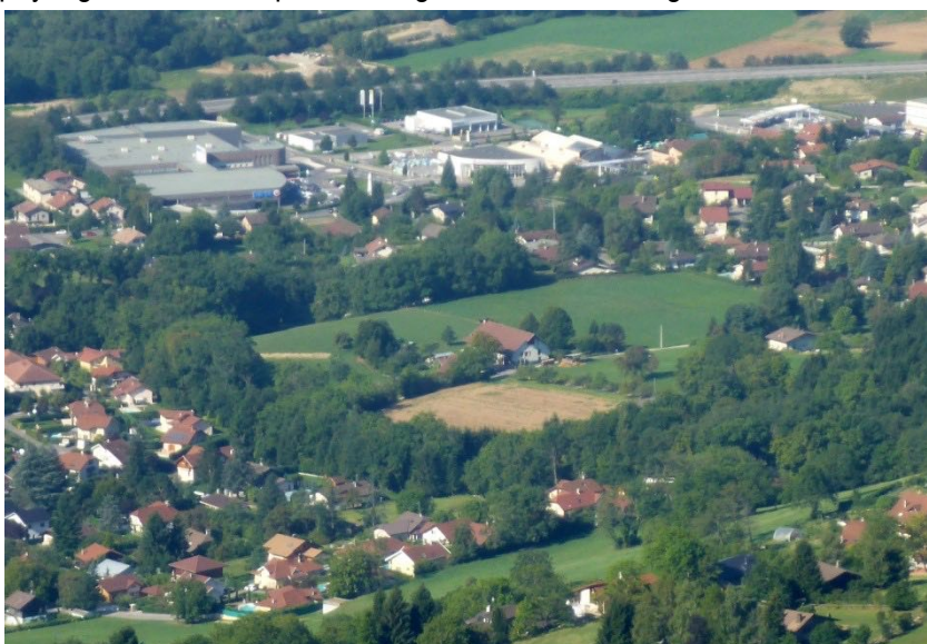
Vue du secteur bâti au droit du Ruisseau de Chamagnou. Une diffusion du bâti qui efface progressivement les anciens repères hérités de l'activité agricole, sans pour autant parvenir à composer une structure urbaine lisible et porteuse de sens à l'échelle du paysage.
