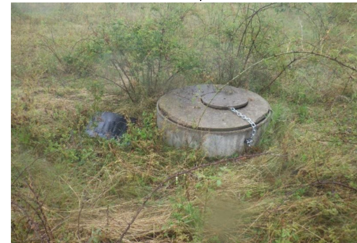
Regard de visite alvéole n°2*
