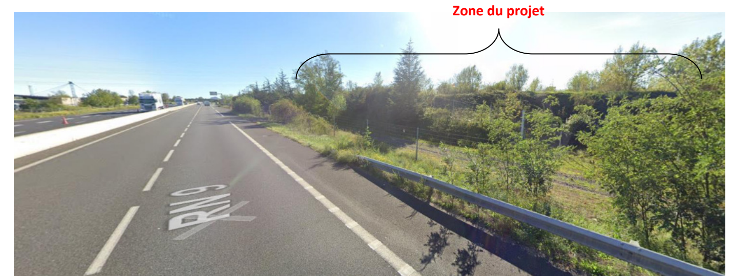
Figure 124 : Vue de la zone d'étude depuis l'A75 en venant du nord
