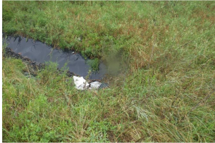
Fossé étanche entre alvéoles n°2 et 3, et passage busé au niveau d'une passage véhicules (traces de roue dans la végétation)
