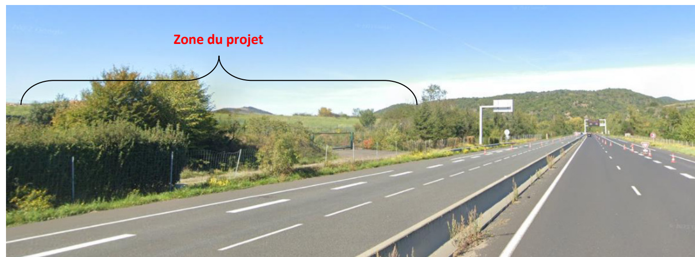
Figure 137 : Vue de la zone d'étude depuis l'A75 en venant du sud
