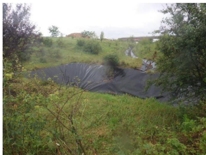
Bassin existant de collecte des eaux pluviales et fossé en provenance de l'Ouest
