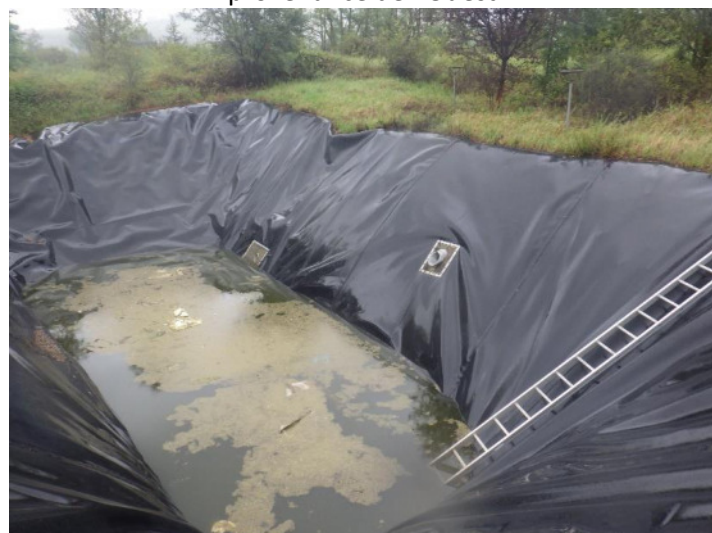
Bassin de collecte des eaux pluviales, vue des 2 canalisations exutoires
