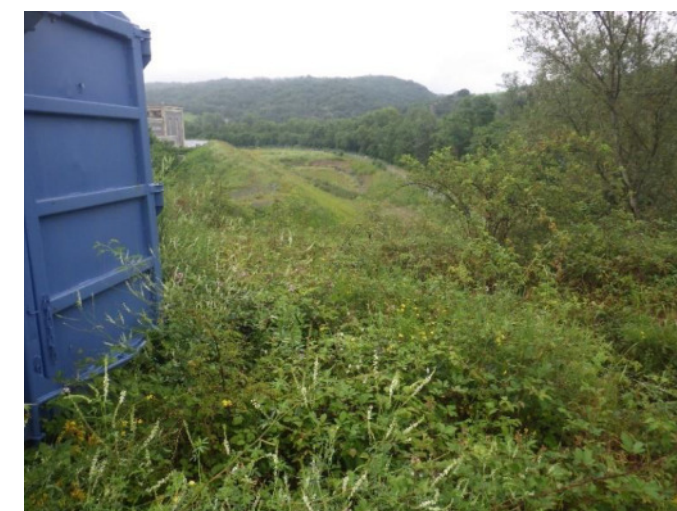
Vue du talus Nord, depuis le coin Nord-est du site
