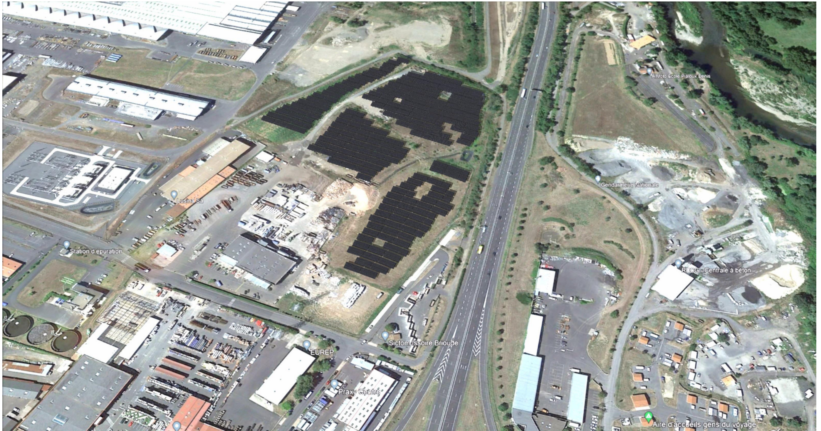
Figure 145 : Vue aérienne du projet
