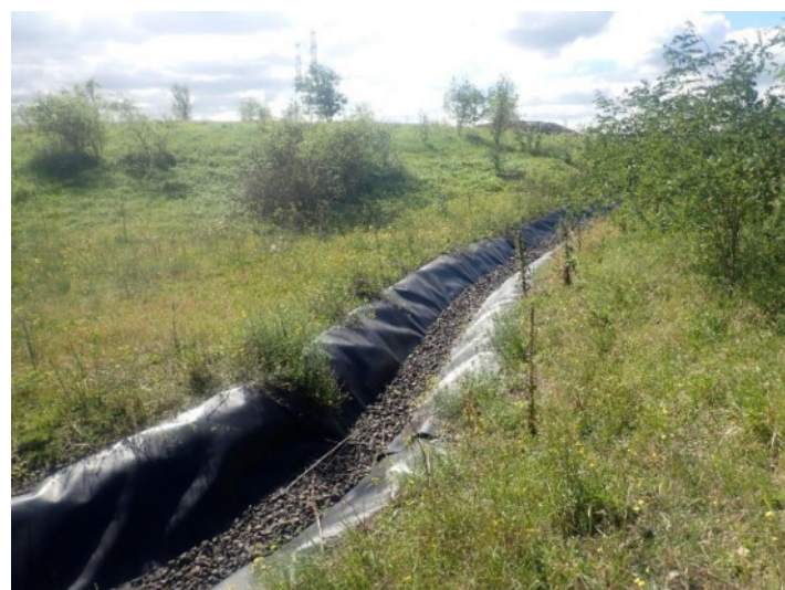
Fossé en provenance de l'Ouest, qui se jette dans le bassin EP
