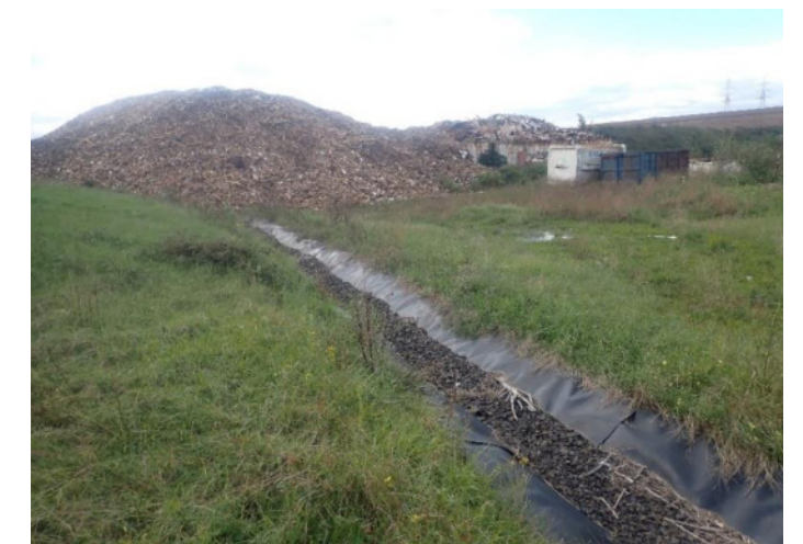
Fossé étanche entre alvéoles n°1 et n°3
