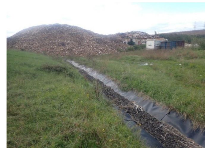
Fossé étanche entre alvéoles n°1 et n°3
