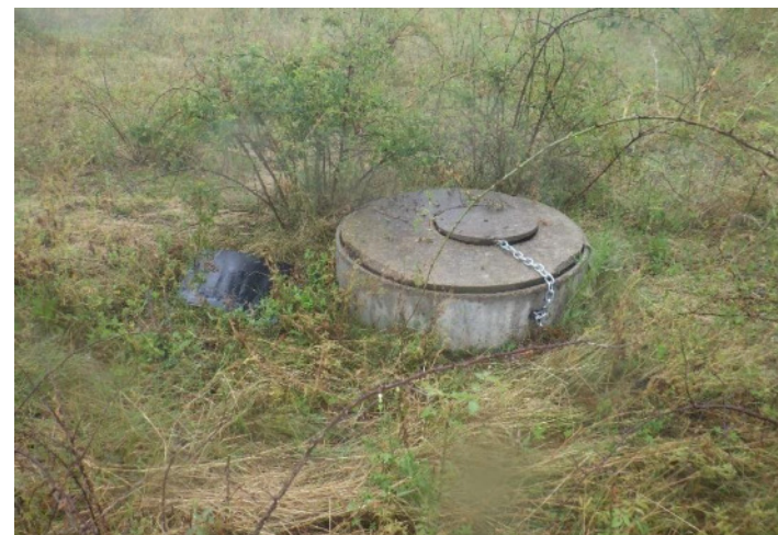
Regard de visite alvéole n°2*
