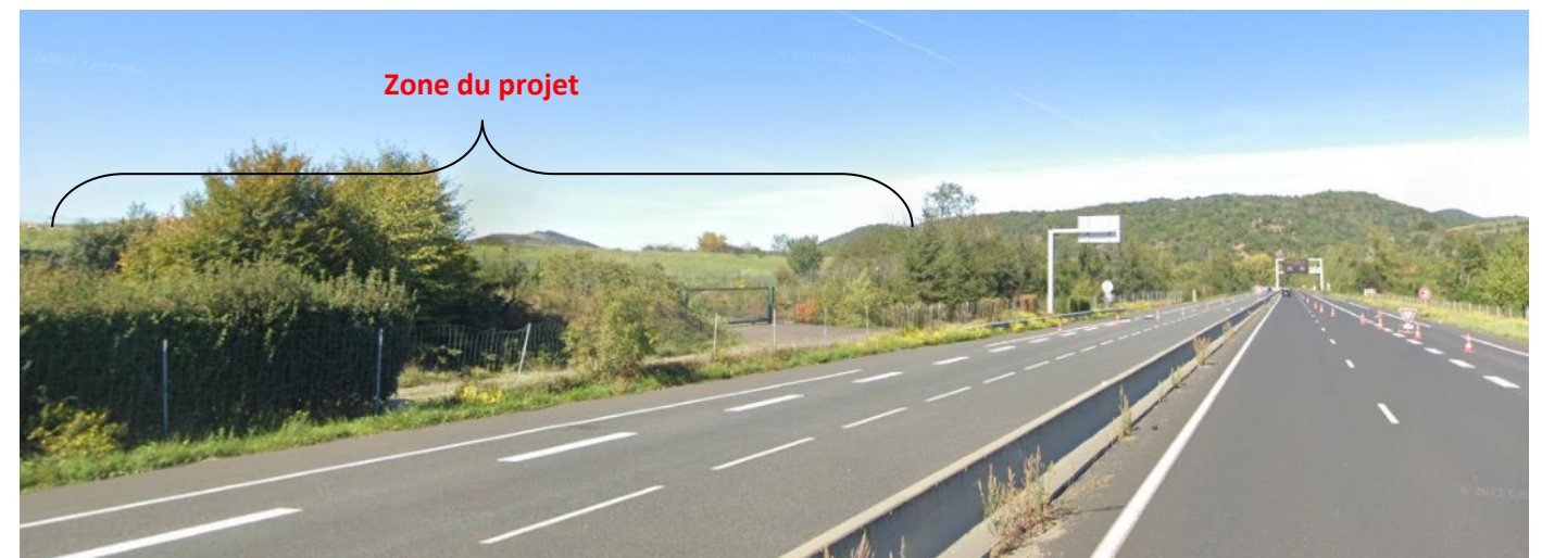
Figure 125 : Vue de la zone d'étude depuis l'A75 en venant du sud
