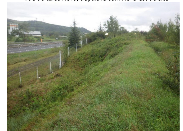
Vue du talus Est, partie Nord.
