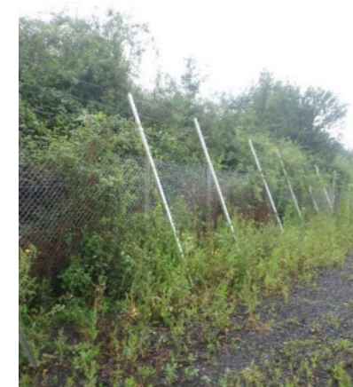
Talus Nord du site, clôture. Très végétalisé et inaccessible depuis le haut comme depuis le bas.
