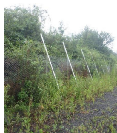
Talus Nord du site, clôture. Très végétalisé et inaccessible depuis le haut comme depuis le bas.
