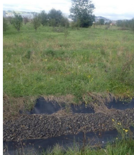
Fossé étanche entre alvéoles n°1 et n°3
