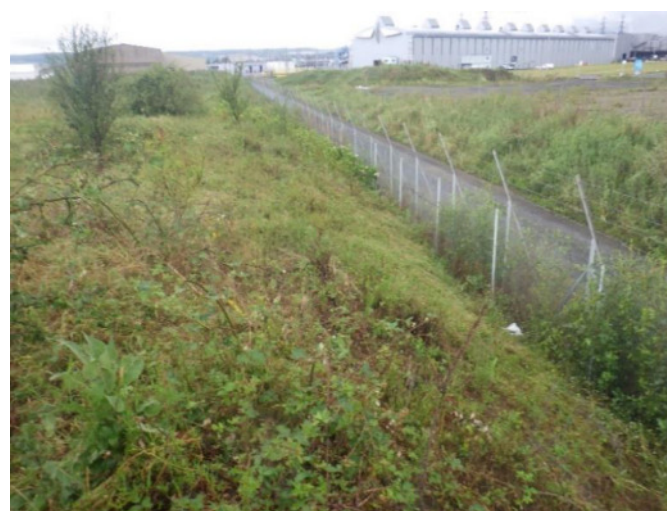
Limite Ouest du site (vue en direction du Sud)
