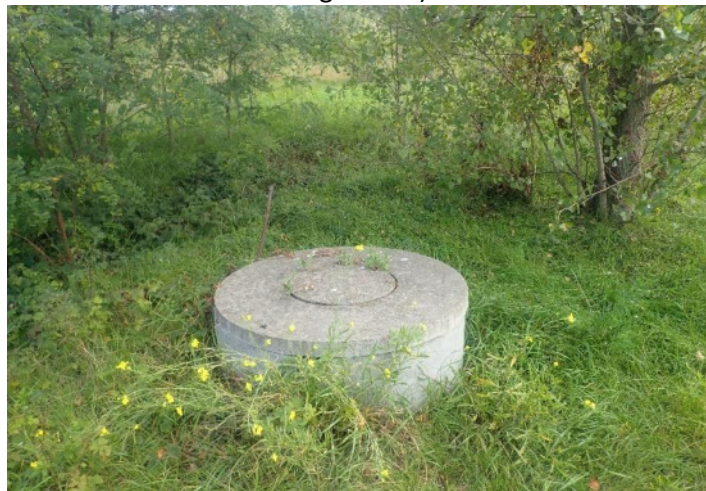
Ouvrage inconnu sur l'alvéole n°1* : probablement un regard de visite, non référencé dans le cadre du suivi environnemental
