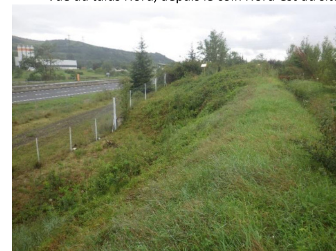
Vue du talus Est, partie Nord.
