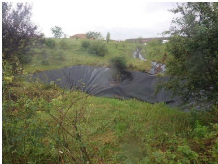
Bassin existant de collecte des eaux pluviales et fossé en provenance de l'Ouest
