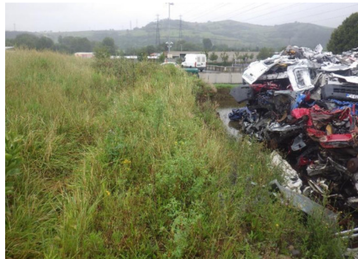
Limite Sud de l'alvéole n°3 : fossé et talus délimitant l'activité Praxy. Pas de clôture, talus très raide.
