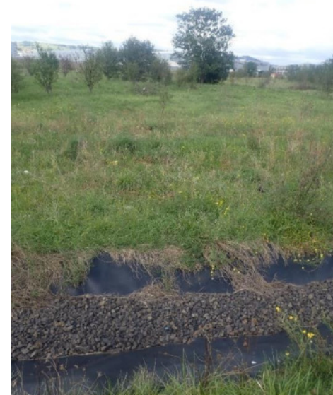
Fossé étanche entre alvéoles n°1 et n°3
