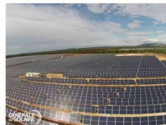
Centrale de Belvezet, Gard
