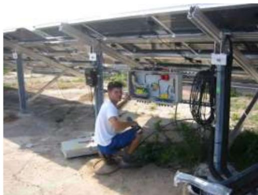
Raccordement de câbles solaires en coffret électrique
