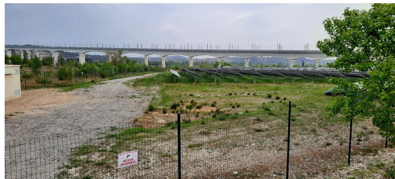
Photographie 17. Vue de l'entité nord du parc photovoltaïque Courtine I
