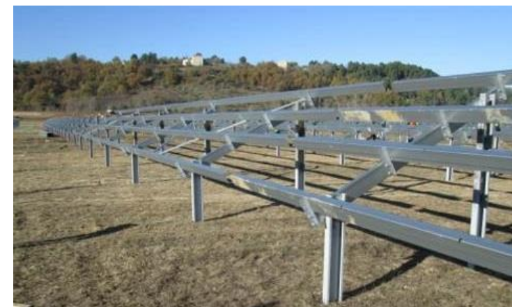
Photographie 1. Structure porteuse (2 ancrages pieux)
