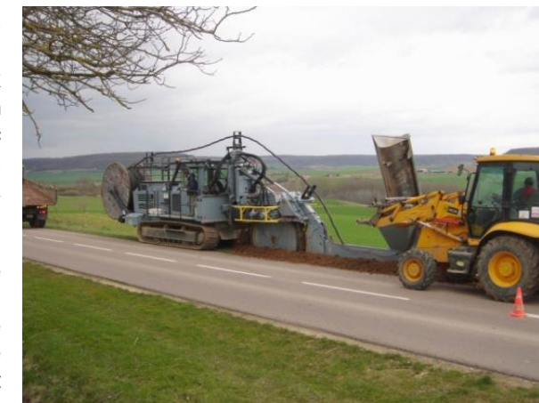
Figure 5. Réalisation de la tranchée
