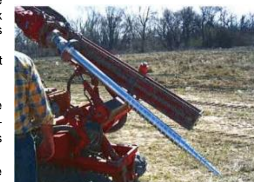
Photographie 3. Mise en œuvre de pieux
