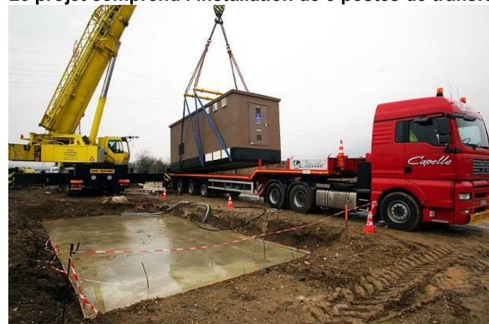
Photographie 6. Installation d'un poste de livraison
