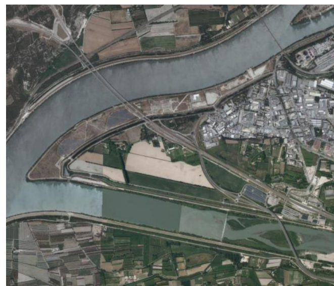
Photographie 33. Vue aérienne 2021
