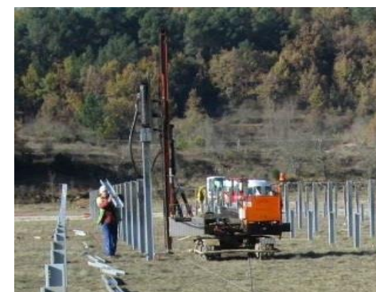
Photographie 4. Battage de pieux
