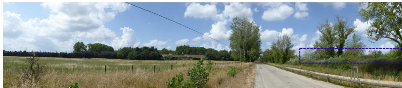
Photo 9 – Bâtiment industriel du Domaine de Courtine à proximité de la limite sud de la ZIP. La ZIP n'est pas visible.
