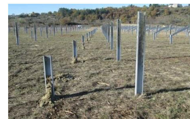
Photographie 5. Ancrage de pieux battus
