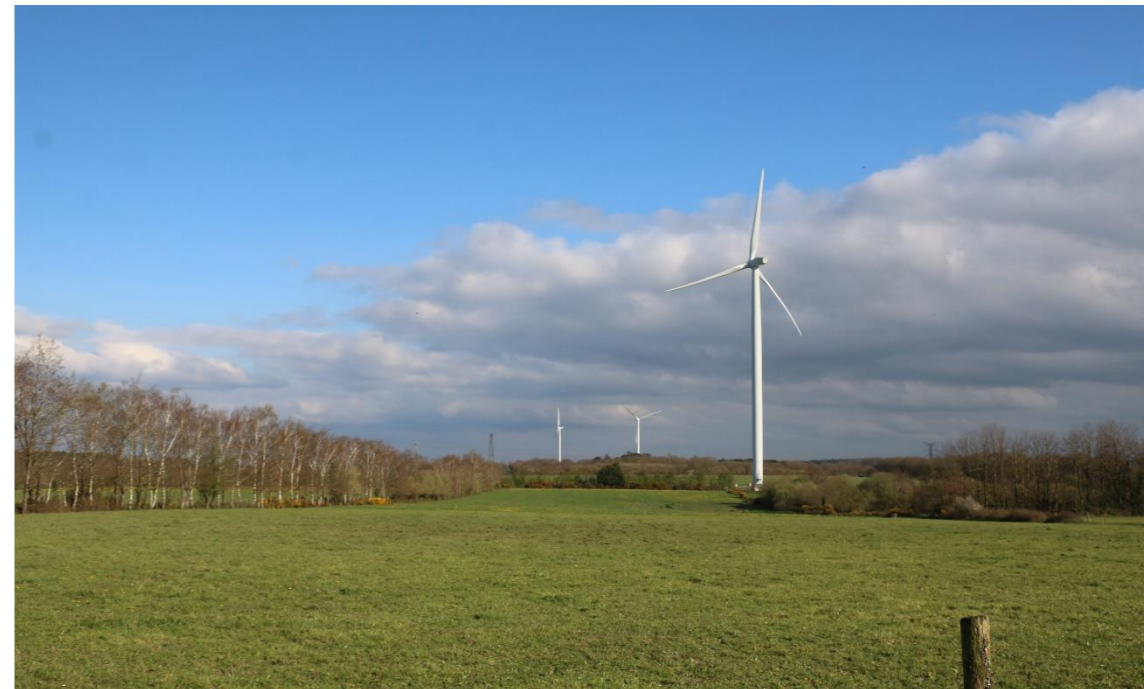
Figure 173. Parc éolien de Séverac
