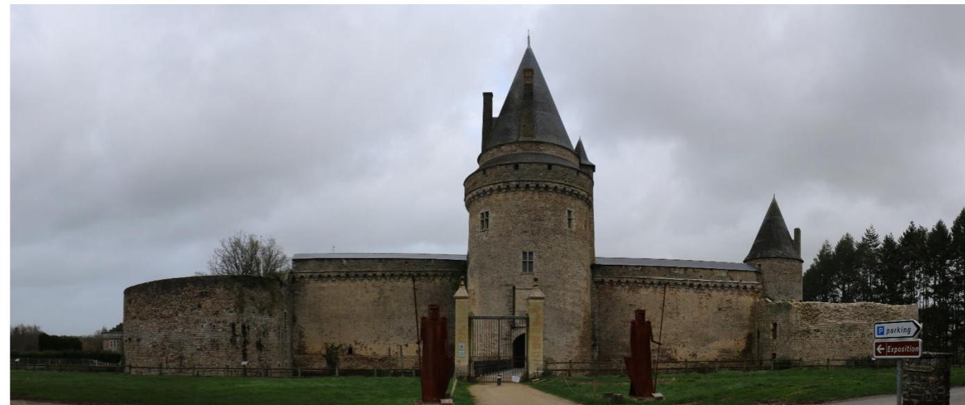
Figure 214. En haut : Château du Pordor (à g.), Chapelle Saint-Georges (à d.). En bas : ensemble sud des parties classées du château de la Groulais
