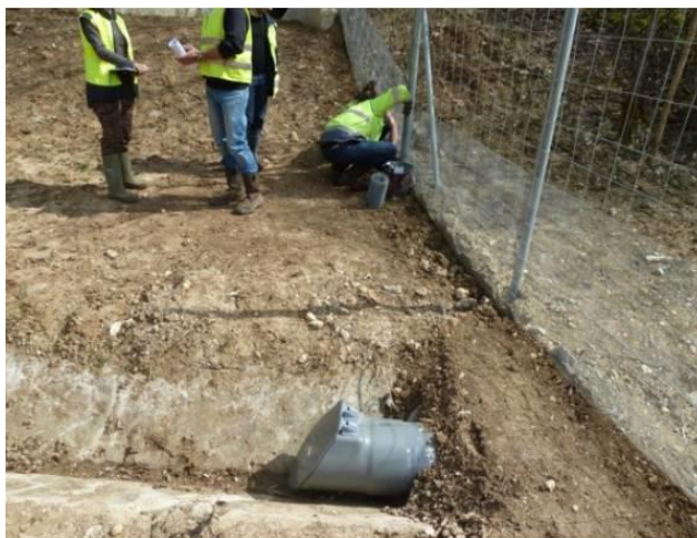
Figure 94 : Exemple de grillage à maille fine installé au bas d'un grillage à maille large
