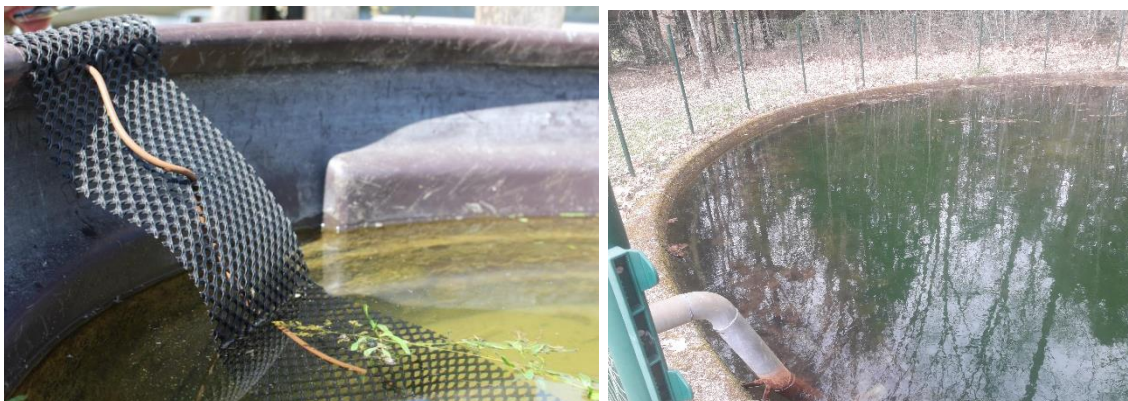
Figure 124 : Rampe échappatoire pour la petite faune (Conseil Départemental de l'Isère) à gauche et bassin présent sur site (à droite) (Source : ECCEL Environnement, juin 2023)
