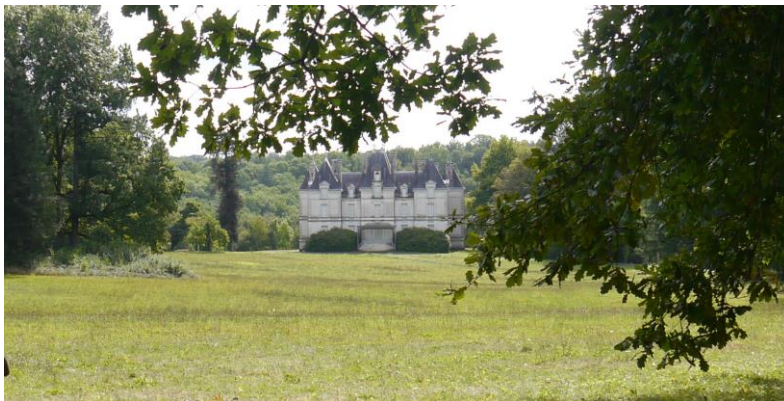
Figure 62 : Photographie du parc et du château (Source : Notice explicative – COCO Architecture, Décembre 2022)
