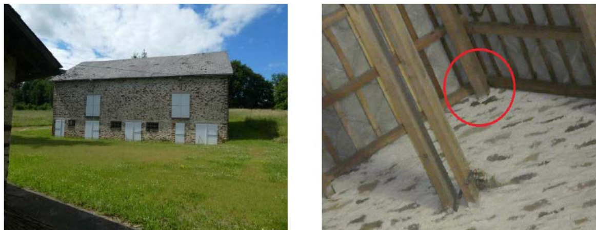
Figure 6 : Etable du hameau de la porte abritant au moins 23 individus de Sérotine commune en gîte de mise bas (Source : Géonat)
