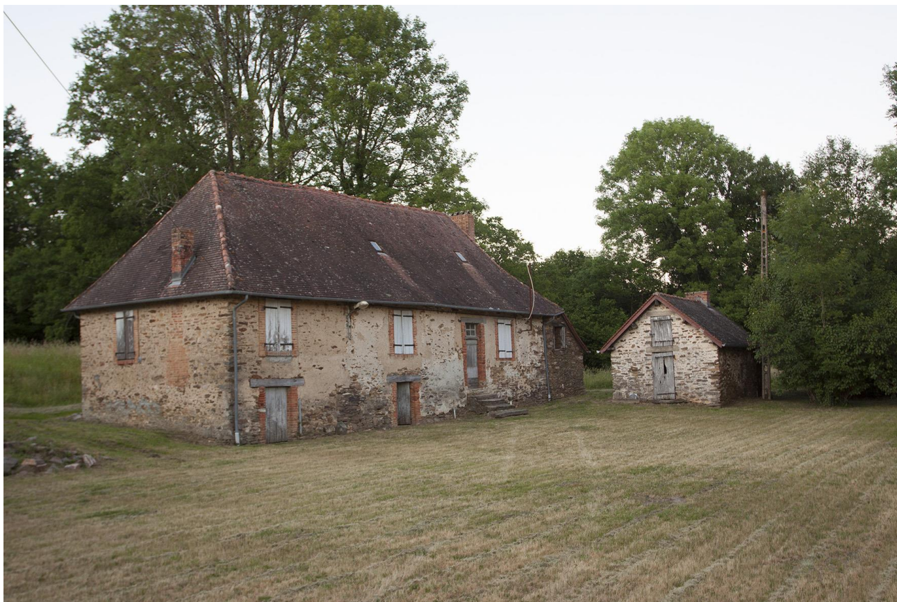
Figure 3 : Maison d'habitation (« dortoir ») du Hameau de la Porte (bâtiment principal, à gauche)
