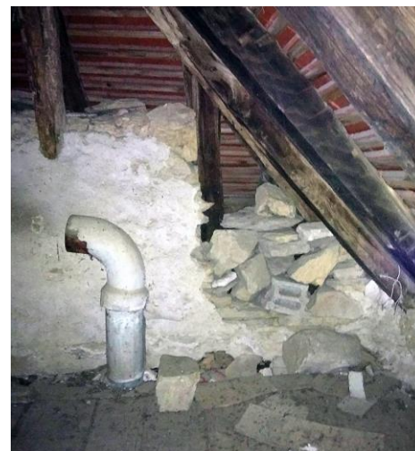
Figure 11 : Accès permettant aux chiroptères de transiter entre les combles et l'appentis.
