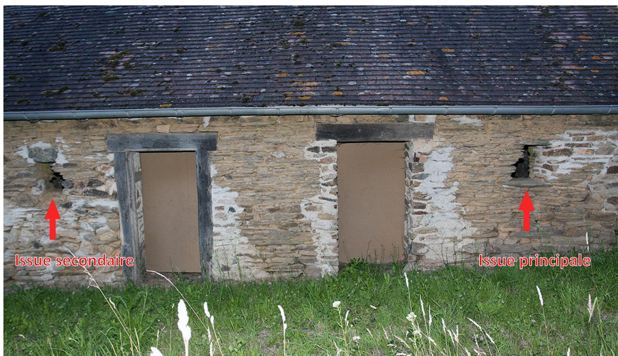
Figure 12 : Situation des issues utilisées par les grands rhinolophes, en façade est de l'appentis.
