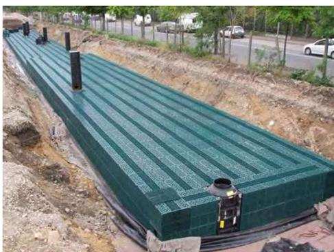
Figure 19 : Exemple de bassin de rétention en SAUL (Structure Alvéolaire Ultra Légère)
