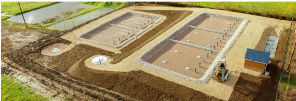
*Figure 1: Exemple d'une construction d'une STEP en filtres plantés de roseaux, avant plantation des roseaux*
