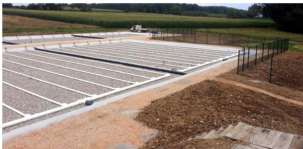
Figure 10: Exemple d'installation de STEP en filtre plantés de roseaux avant plantation des roseaux
