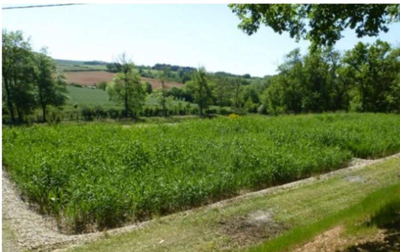
Figure 11: Exemple d'installation de STEP après développement des roseaux
