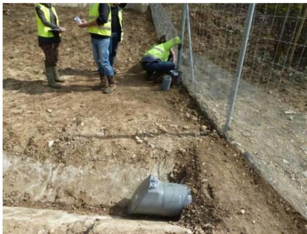
**Figure 66 : Exemple de grillage à maille fine installé au bas d'un grillage à maille large**
