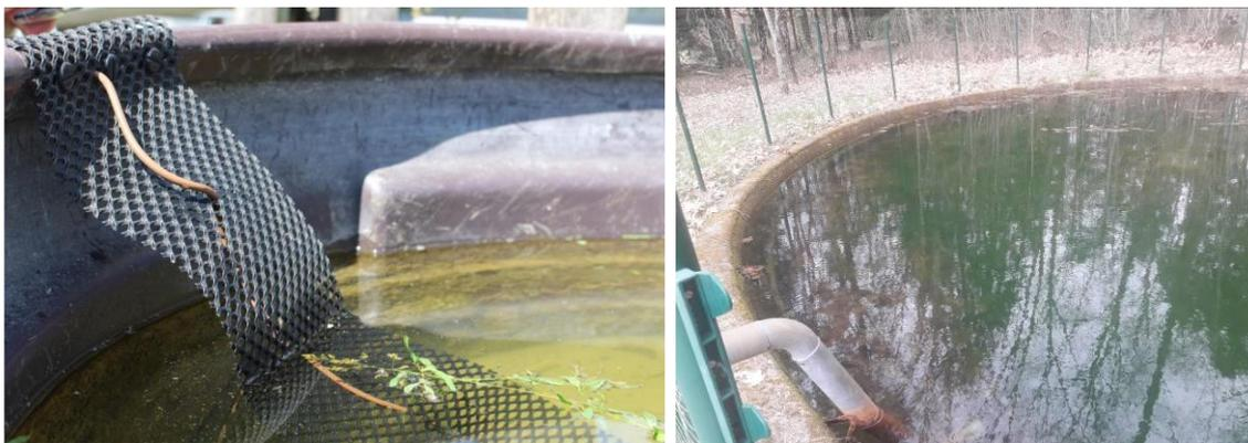
**Figure 97 : Rampe échappatoire pour la petite faune (Conseil Départemental de l'Isère) à gauche et bassin présent sur site (à droite)**
