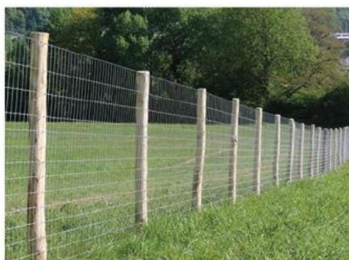
**Figure 86 : Illustration du portail et de la clôture perméable à la petite et moyenne faune qui seront utilisés dans le cadre du projet (Source : DREAMGEST France SAS)**
