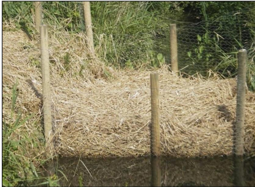
**Figure 74 : Exemple de filtre à paille (Source : INRAP)**
