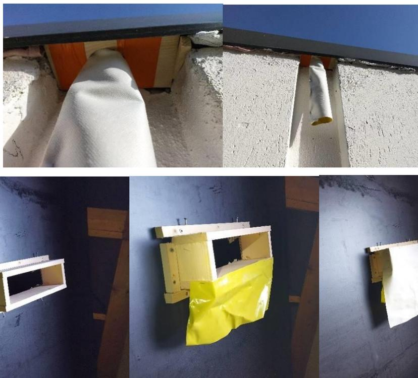
**Figure 76 : Exemple de systèmes anti-retour (Source : Maël Dugué – MD Environnement)**
