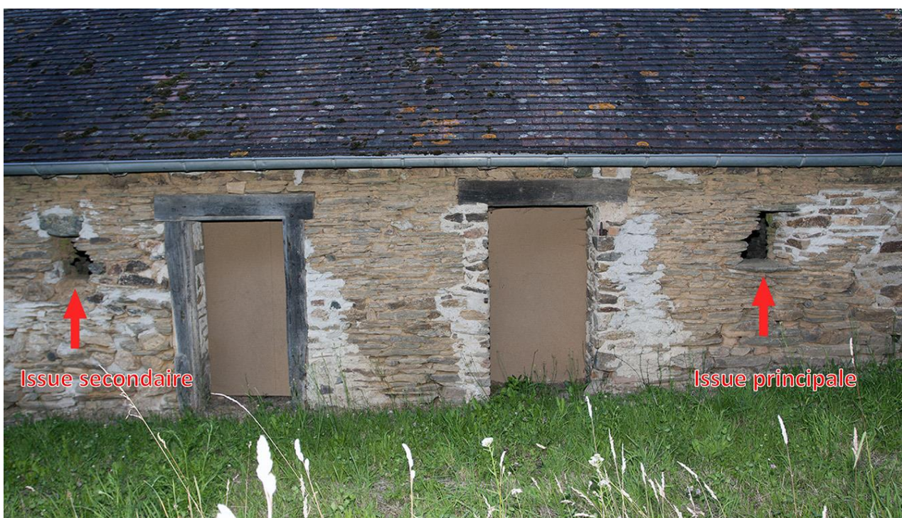
Figure 8 : Situation des issues utilisées par les grands rhinolophes, en façade est de l'appentis.
