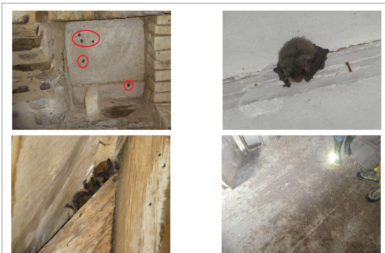
Illustration 79: Gîte de transit et de mise bas multi espèces (5 espèces observées) dans le Château, vue des Petits rhinolophes dans les caves, de l'Oreillard gris à l'étage et d'un groupe de Pipistrelles communes dans le grenier (+ Guano de grandes espèces type Grand rhinolophe, observé par ailleurs dans le grenier) (Source : Oxalis SCOP)
