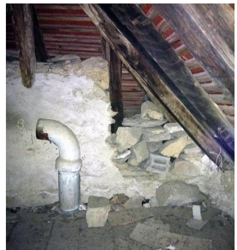
Figure 7 : Accès permettant aux chiroptères de transiter entre les combles et l'appentis.
