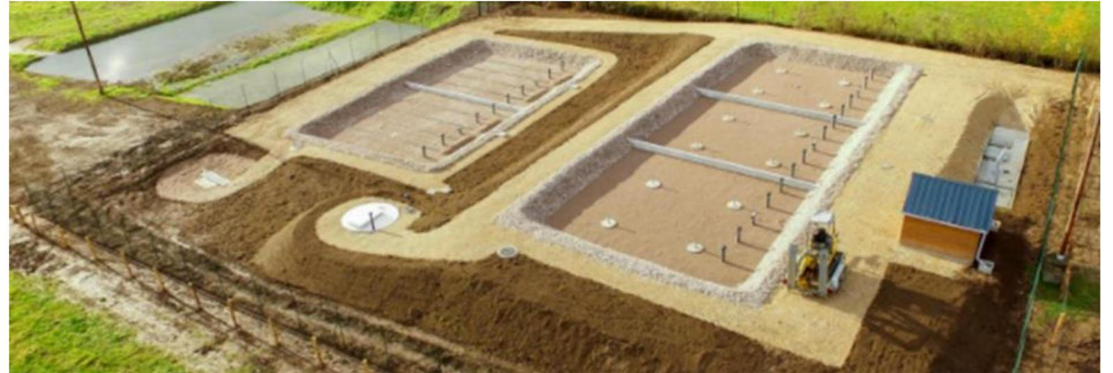
Figure 1 : Exemple d'une construction d'une STEP en filtres plantés de roseaux, avant plantation des roseaux
