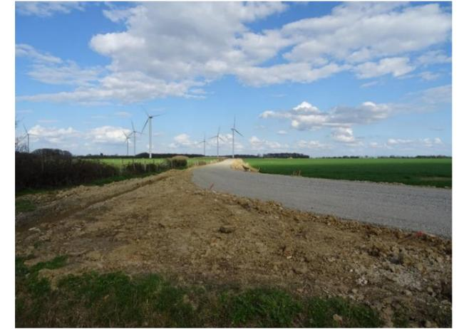
Les pistes seront stabilisées sur 4,5 mètres de large de manière à supporter le passage des engins pour la construction. La structure des pistes sera composée de plusieurs couches :
