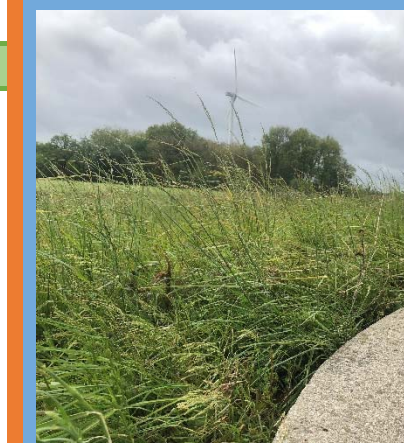
Pied d'éolienne non entretenu
