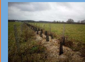
Photo prise en phase travaux constatant l'implantation d'une haie
