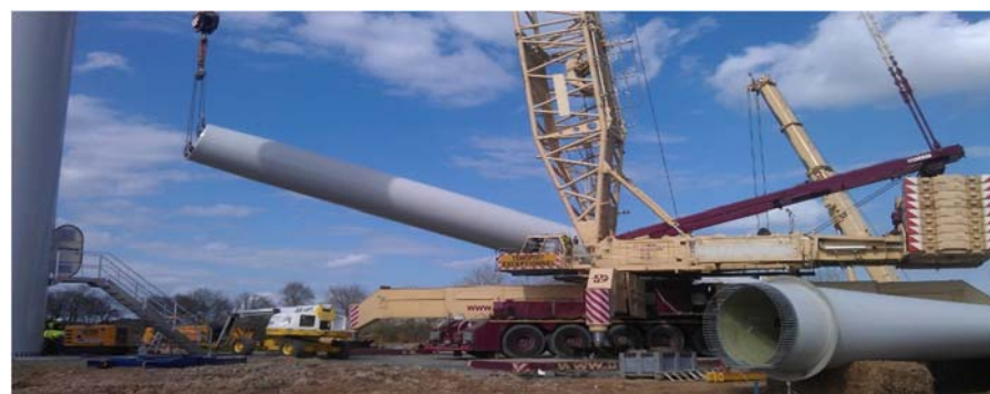
Photo 21. Grue de levage pour plateforme
