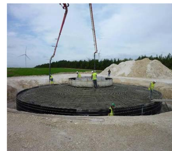
Photo 20. Construction d'une fondation
