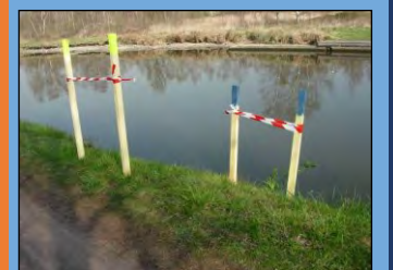
Exemple de balisage de station d'EEE
