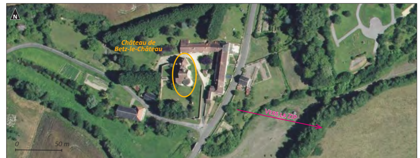
Illustration 26. Implantation du château de Betz-le-Château Source : Géoportail
