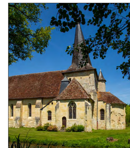
Photographie 36. Église paroissiale Saint-Pierre [2]
