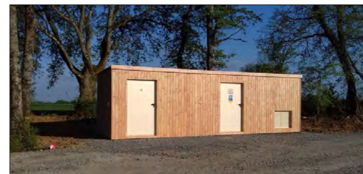
Photographie 76. Exemple de poste de livraison habillé d'un bardage bois Source : Eurocape
