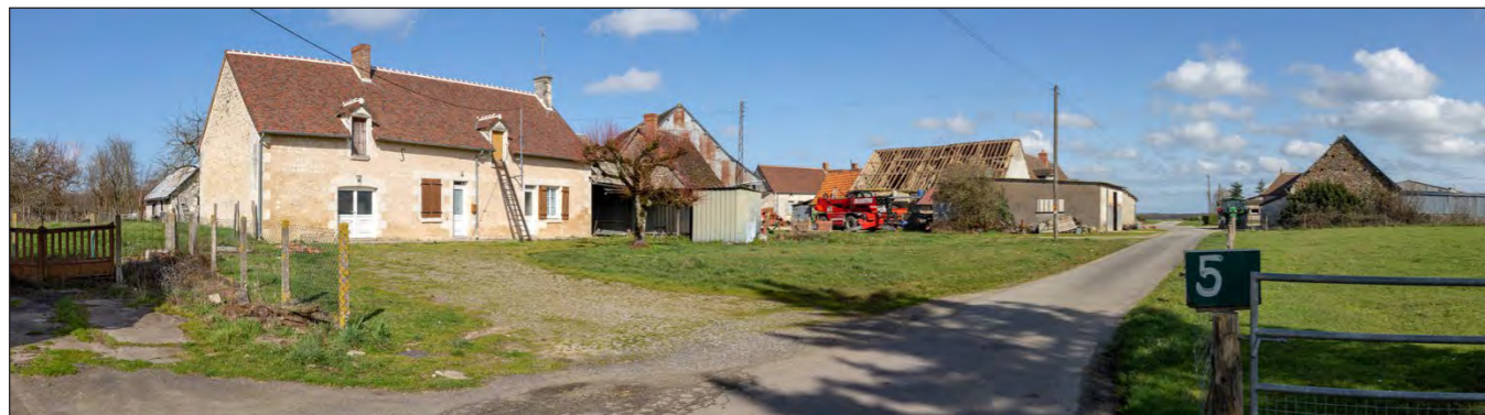
Photographie 69. Depuis l'intérieur de la Cornetterie (Charnizay)
