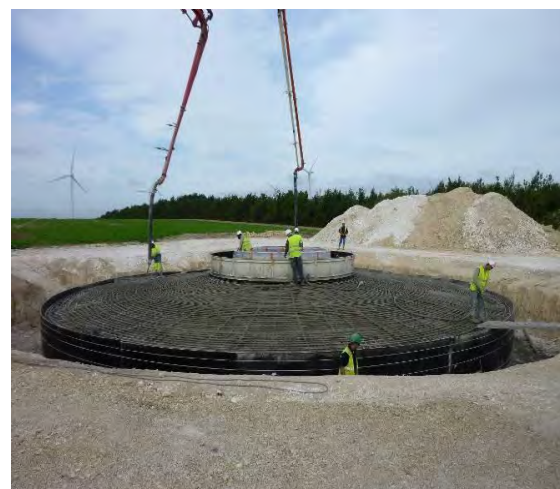
Photo 1. Construction d'une fondation
