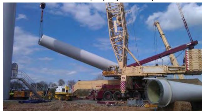
Photo 2. Grue de levage pour plateforme
