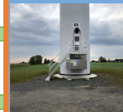
Plateforme et pied d'éolienne entretenu
