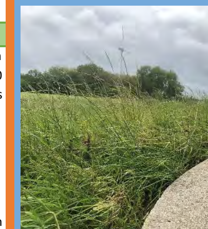
Pied d'éolienne non entretenu
