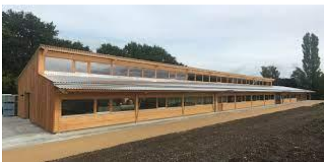
Exemple d'atelier à ossature bois avec conception bioclimatique.
