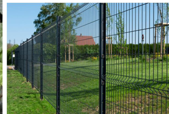
Clôtures surélevées de 20 cm permettant le passage de la petite faune. Ces clôtures seront végétalisées avec du lierre.
