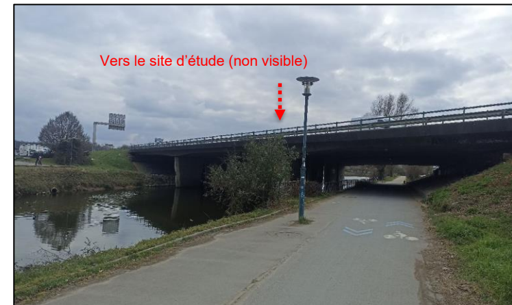
Figure 90 : Vue I, depuis le halage de l'autre côté de la rocade : l'ouvrage masque l'essentiel des vues
