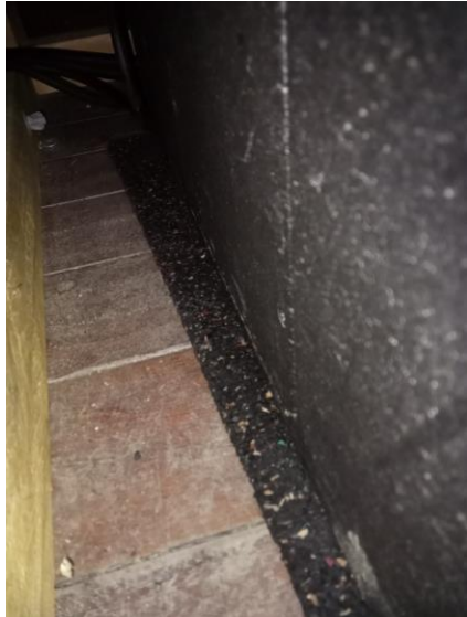
Photo 27: mousse alvéolée installée sous les caissons de basse
