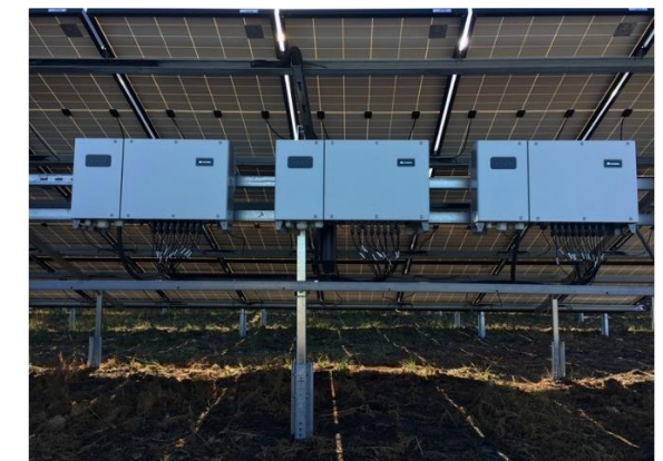
Figure 294 : Exemple d'onduleurs String (source : Cévennes Energy)
