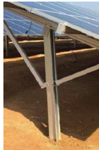
Figure 292 : Exemple de pieu battu (source : Cévennes Energy)
