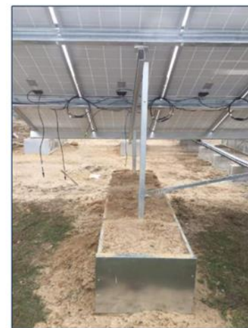
Figure 293 : Exemple de gabion (source : Cévennes Energy)
