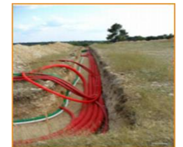
Figure 295 : Règles de l'art pour les câbles enterrés (à gauche) et exemple d'enfouissement de câbles (à droite) (source : Cévennes Energy)
