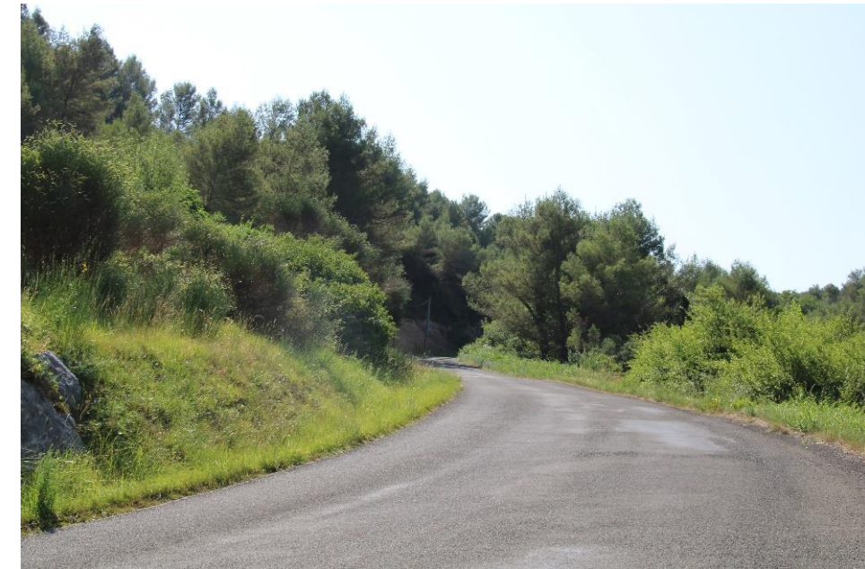
Figure 201 : La route D46 serpentant sur les reliefs – juillet 2021 (source : Territoires & Paysages)
