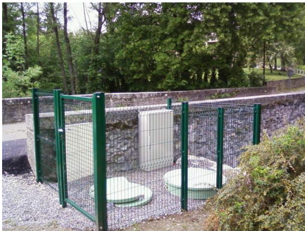
Photographie 1 : Photo type un poste de refoulement
