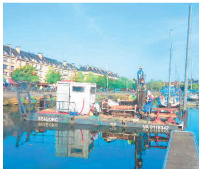
Figure 2 : Ponton Seaborg équipé d'une TB 175
