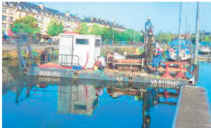
Figure 1 : Ponton Seaborg équipé d'une TB 175 (photo GEOTEC, Bassin Saint-Pierre, Juillet 2018)
