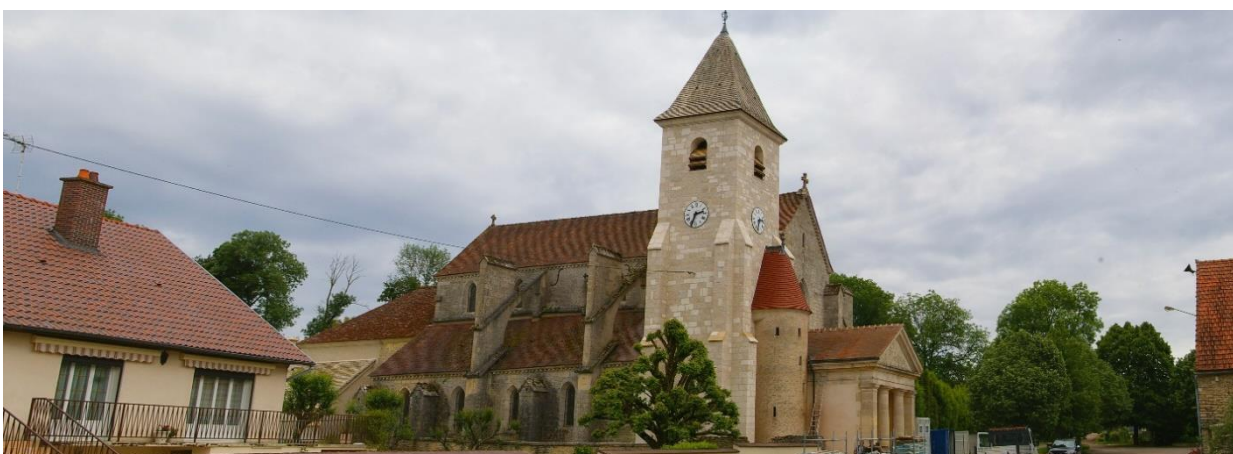
Figure 83 : L'Église Saint-Pierre à Minot
