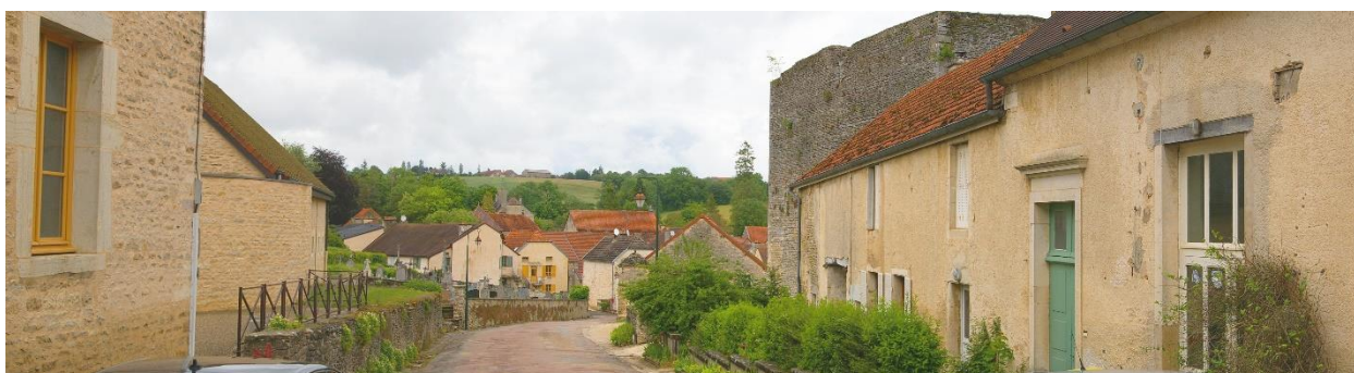
Figure 72 : Salives, installé le long de la D19 et de la D19d (Biotope)
