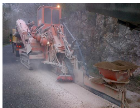
Figure 41 : Photo de trancheuse prise sur chantier
