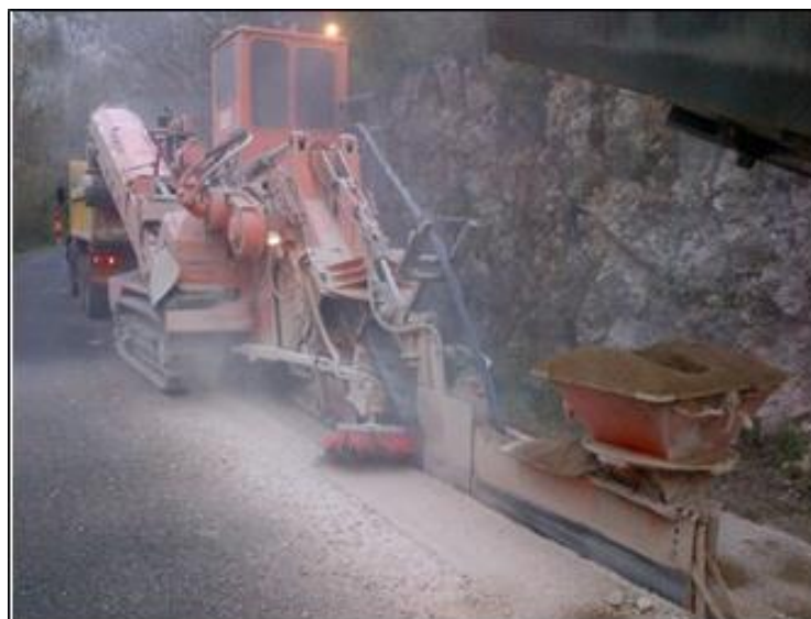
Figure 16. Enfouissement des câbles électriques- Source : wpd Solar
