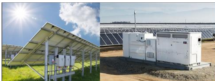
Figure 9 : Types d'onduleurs – Source : Étude d'impact
