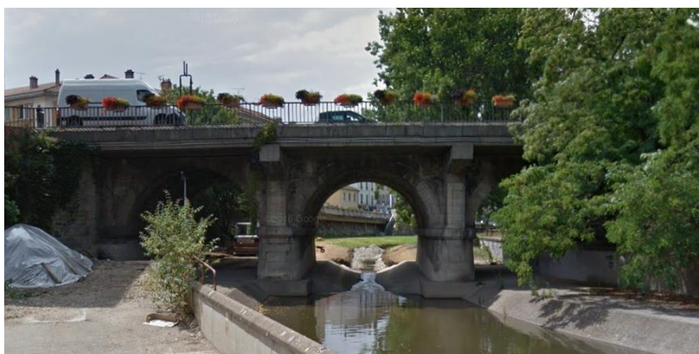
Figure 7 : Pont d'Oullins (RD486) – Point de conflit de la trame bleue
