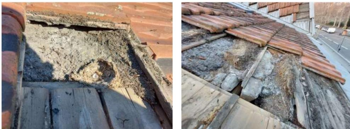
Figure 35 : Détuillage ayant permis de découvrir des nids de martinets et de moineau lors d'une opération de mise en défens dans la commune de Villeurbanne.
