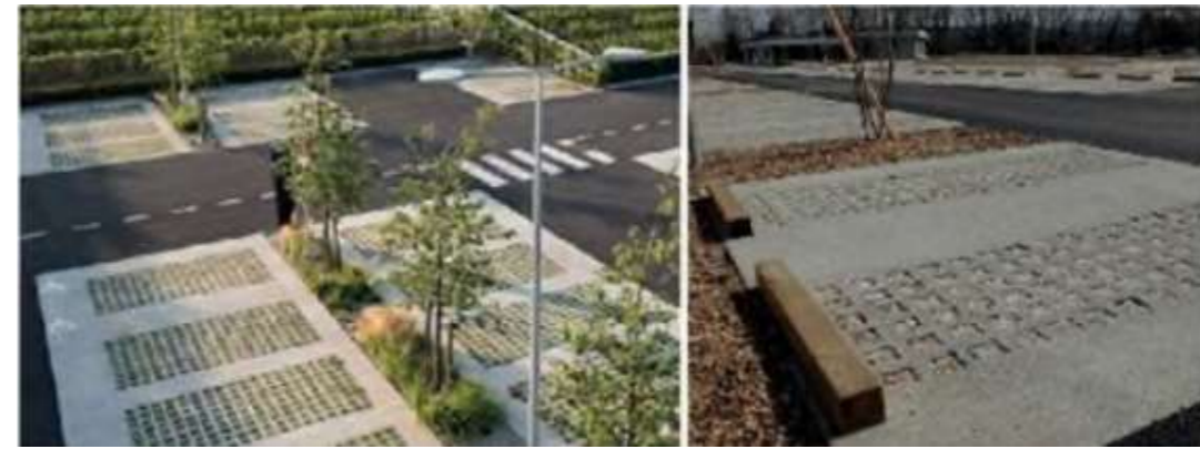
FIGURE 23 : EXEMPLE DE STATIONNEMENTS PERMEABLES – QUARTIER JASMIN A CAYENNE (A234, AVP 2020)
