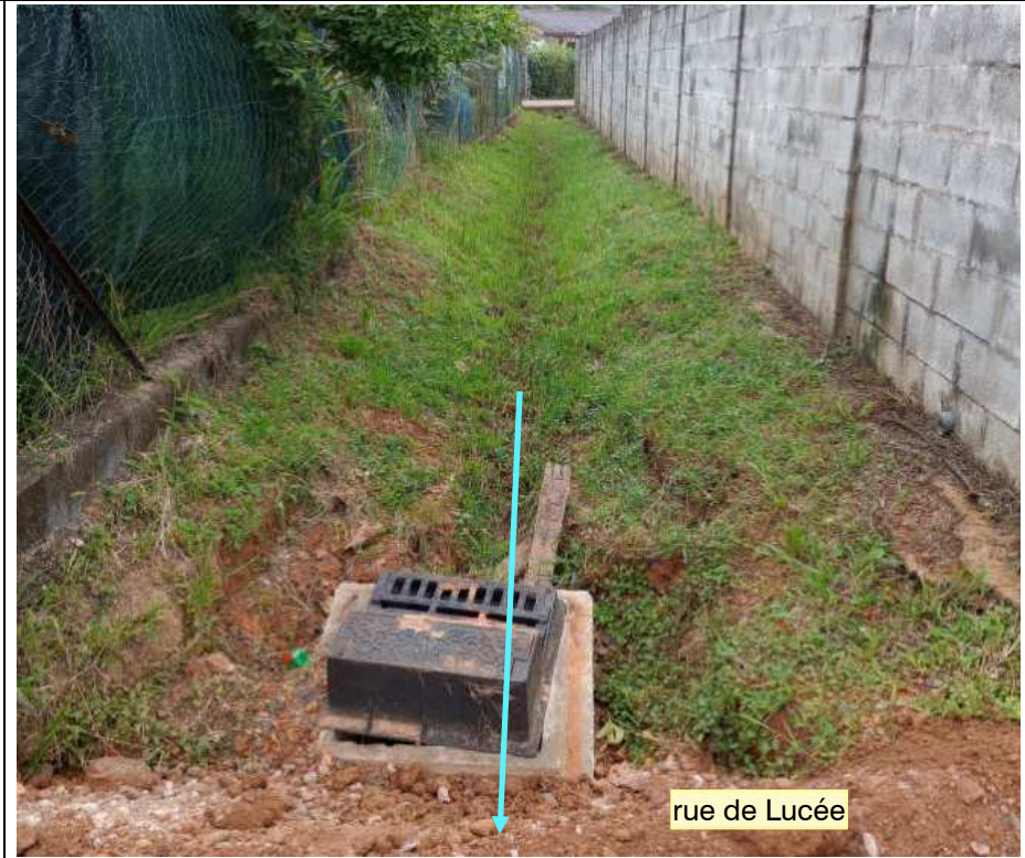
Secteur 4 : raccordement d'un fossé vers le cadre de la rue de Lucée
