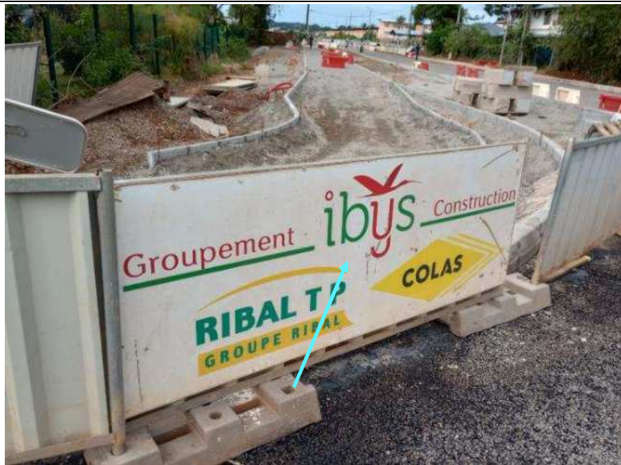
Secteur 2 : vue des travaux rue de Lucée
