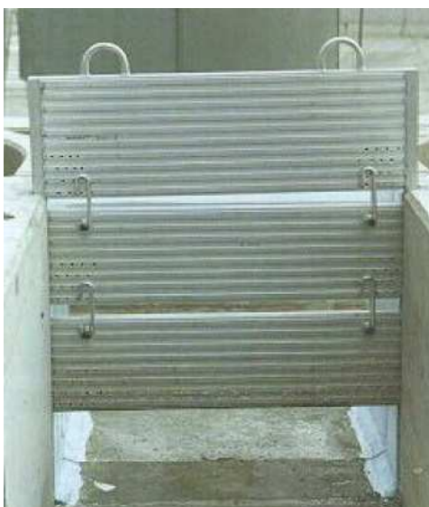
Figure 5 : exemple de batardeau
