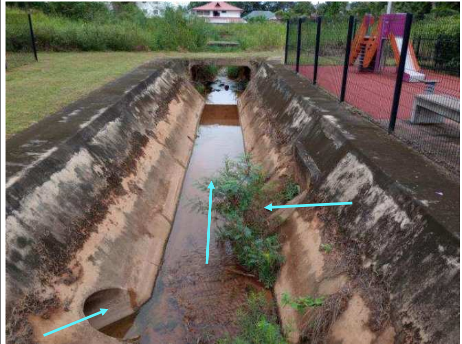
Secteur 2 : vue du fossé canalisé On distingue l'arrivée des buses pluviales du lotissement
