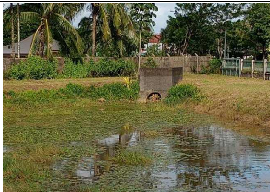
Secteur 1 : vue de l'ouvrage de fuite vers le réseau pluvial de la route de Tarzan
