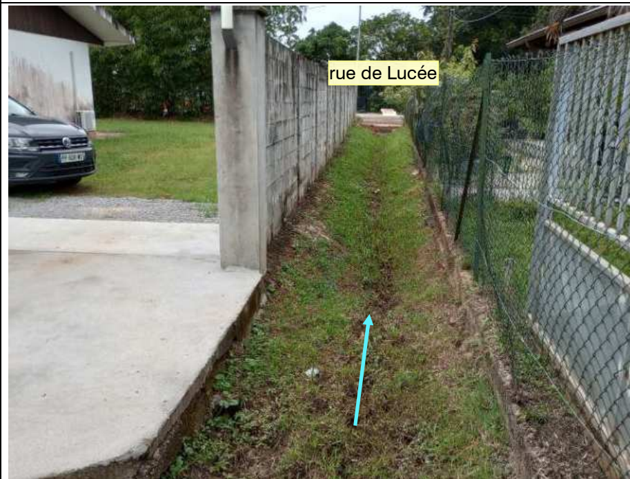
Secteur 5 : impasse du Cacaoyer : raccordement du fossé au cadre de la rue de Lucée
