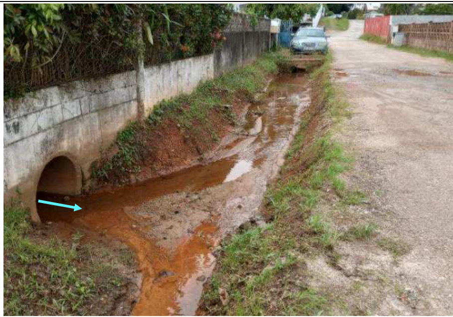
Secteur 1 : rue de l'Amarante – point bas Vue de l'exutoire d'une buse qui passe sous les habitations
