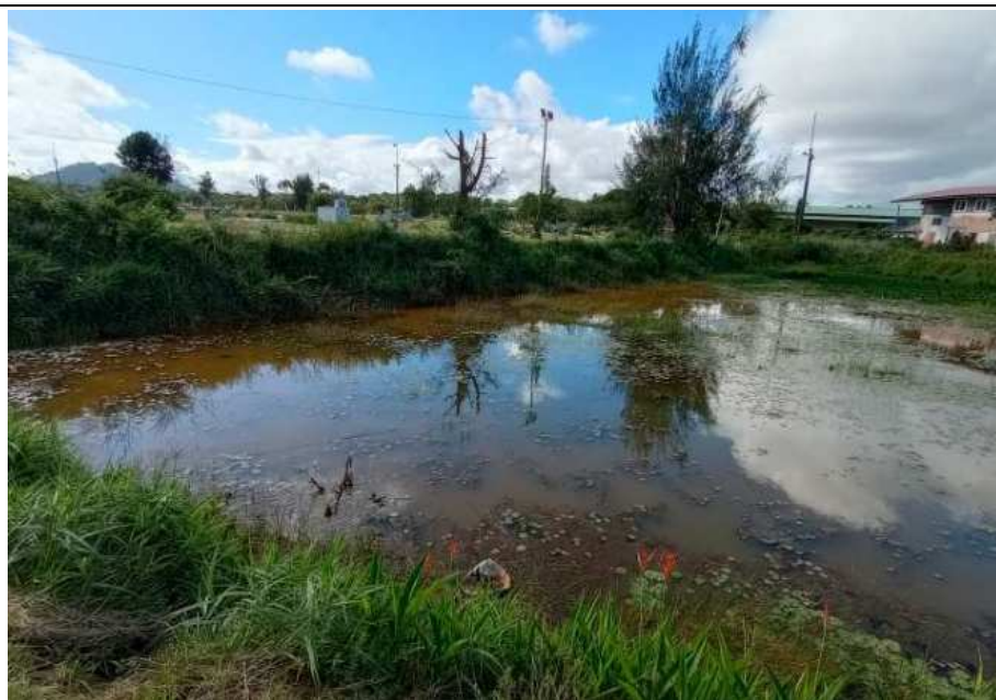
Secteur 1 : vue du bassin de rétention
