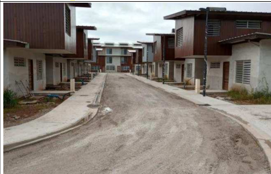
Secteur 2 : pluvial busé avec les travaux du lotissement
