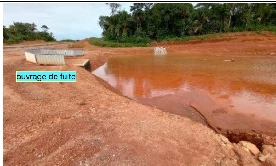
Secteur 1 : vue générale du bassin ROSERAIE – janvier 2023
