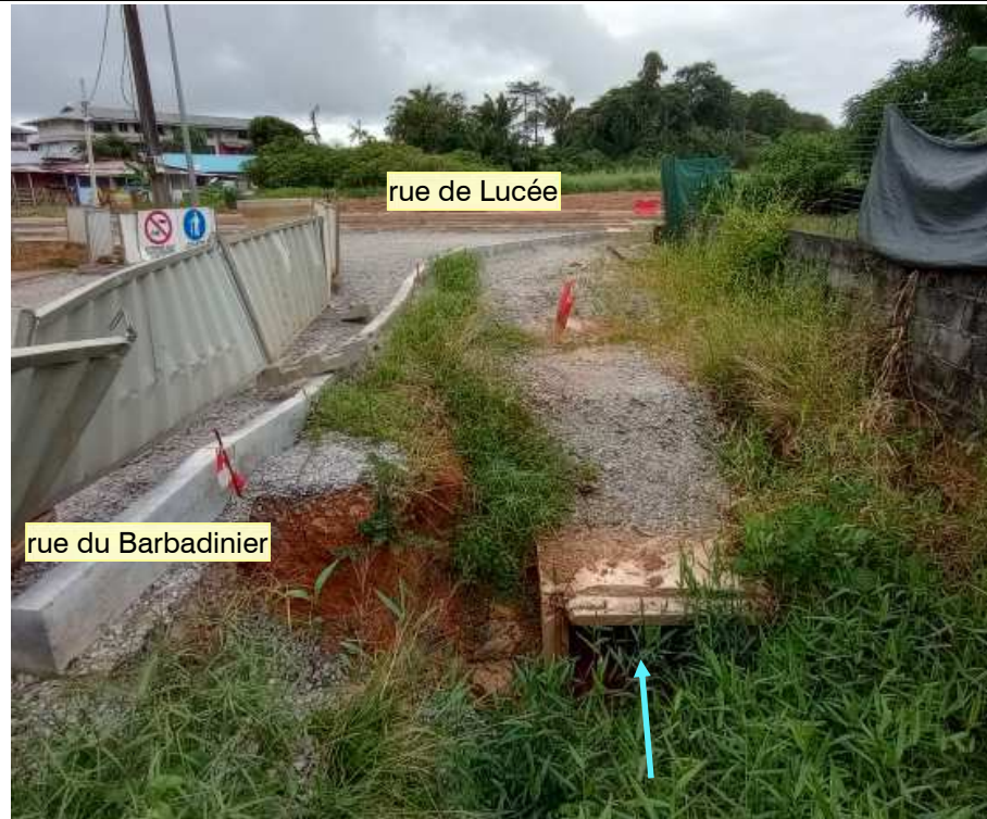
Secteur 3 : vue du raccordement du fossé de rue du Barbadinier au cadre de la rue de Lucée
