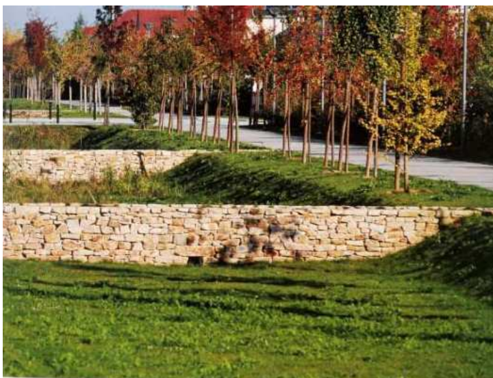
Figure 4 : illustration de noue enherbée et de noue à redan
