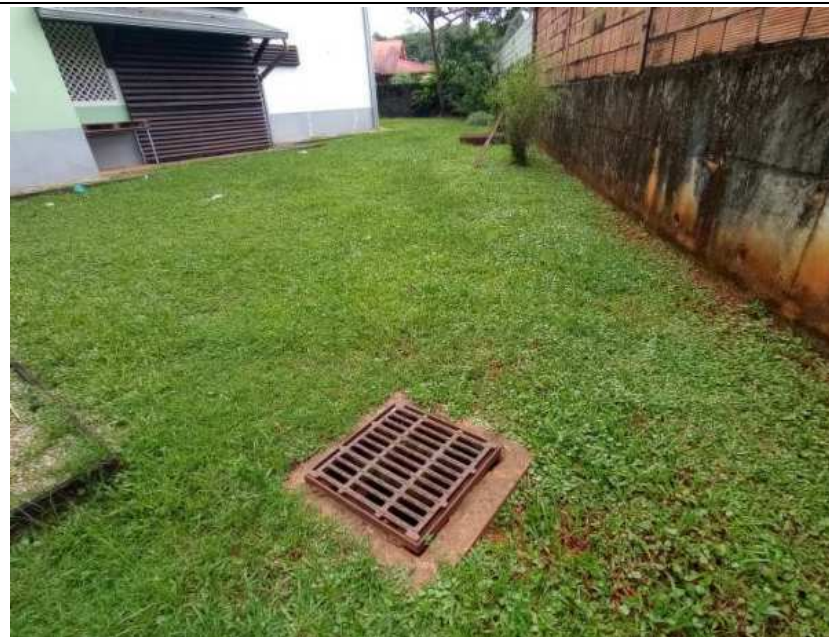
Secteur 2 : résidence Approuague – point bas Vue d'une grille pluviale venant de la rue de l'Amarante
