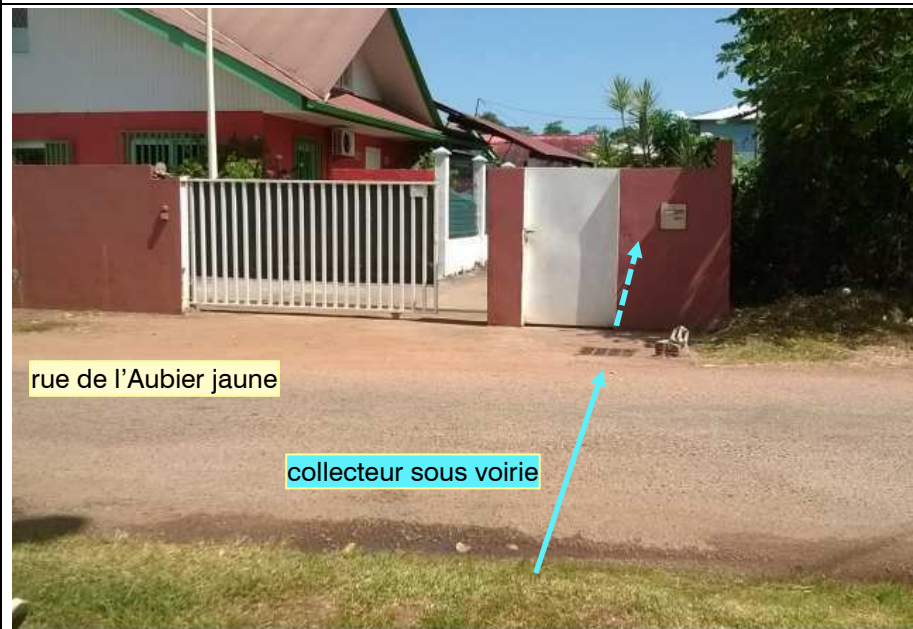
Secteur 3 : rue Aubier jaune Passage sous voirie puis sous l'habitation
