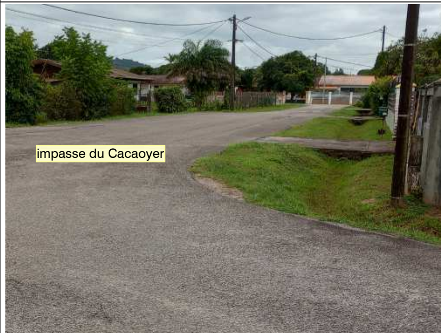
Secteur 5 : impasse du Cacaoyer : vue du fossé pluvial
