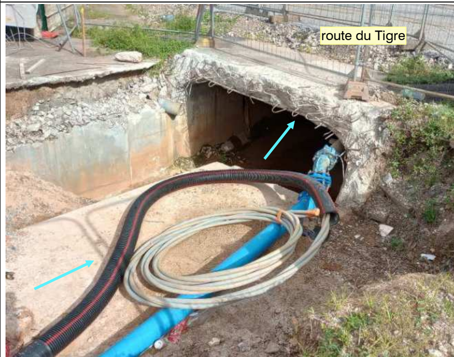
Secteur 3 : vue du cadre existant sous la route du Tigre et fin du cadre de la rue de Lucée
