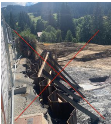
Exemple d'excavation de la totalité d'une unité foncière en vue de réaliser des sous-sols
