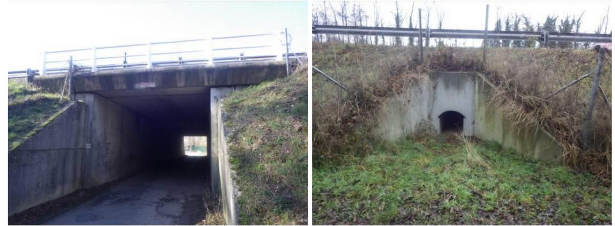
Illustration 48 : Passage inférieur utilisé par la mésofaune au droit de la route du Lac et buse sèche aménagée en faveur de la petite faune au niveau du marais du Vernais (à droite)
