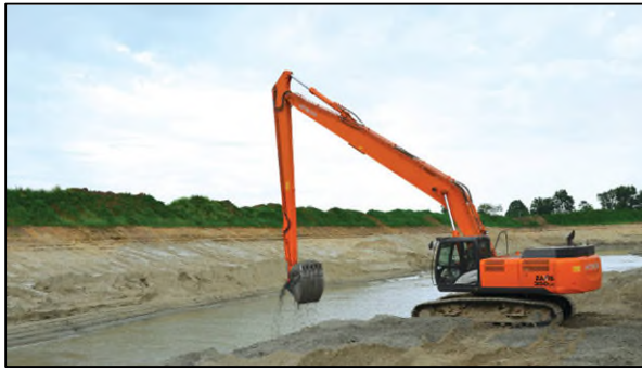
Figure 25. Pelle à long bras (à droite) et dragueline (à gauche)
