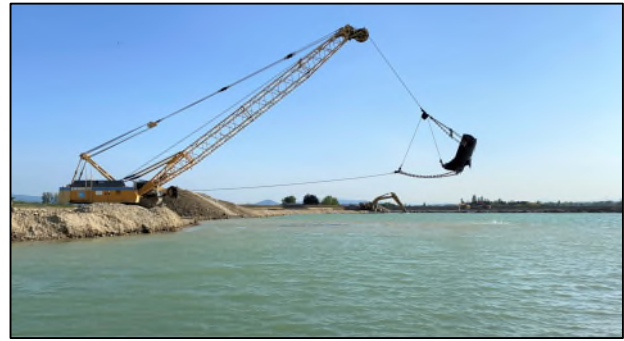
Figure 25. Pelle à long bras (à droite) et dragueline (à gauche)
