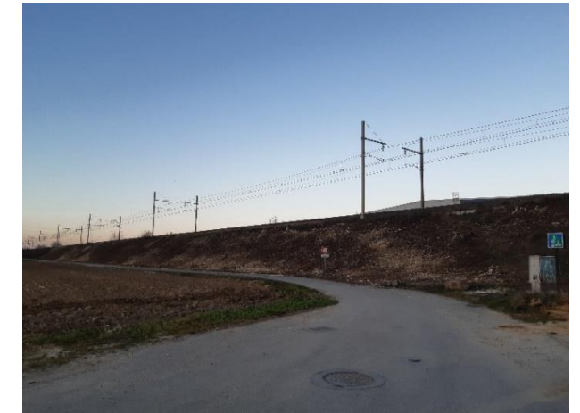
Ronciers et talus SNCF broyés le 13/02/23
