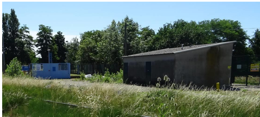
Photographie 5 : Postes Gaz et Hydrogène sur le site de la ZAC INSPIRA (Egis, Benoit Desille, juillet 2020)
