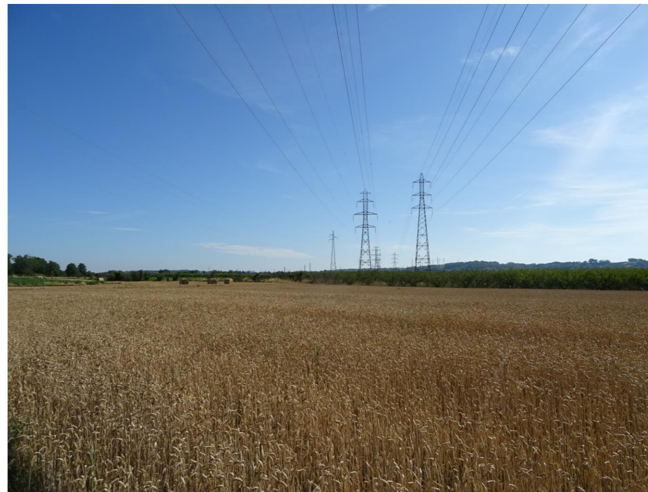
Photographie 23 : 2 lignes haute tension au Sud de la ZAC INSPIRA (EGIS Benoit Desille juillet 2020)
