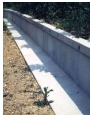
Figure 66 : Exemple de mise en place de bardage autour des passages à faune (en lieu et place du bardage béton il s'agira d'un bardage bois) © AVP MS12
