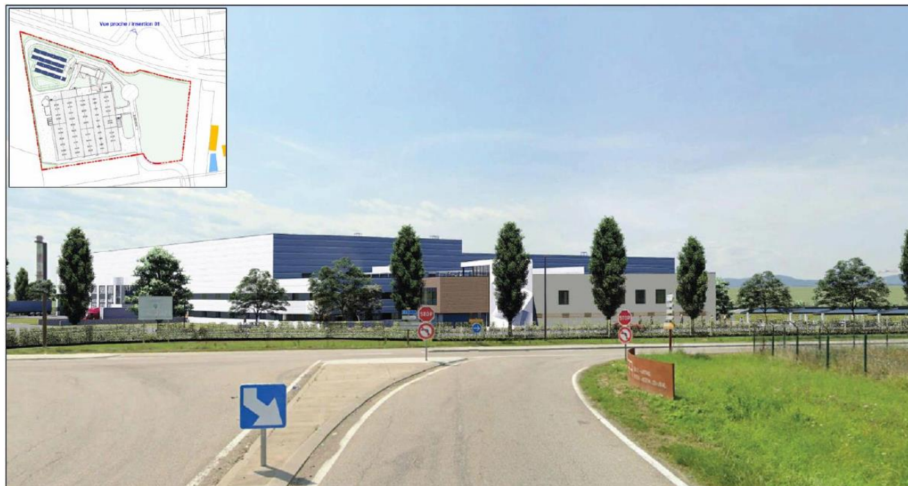
Figure 185 - Insertion du projet dans le paysage - Vue proche depuis l'intersection de la Rue Denis Papin et la RD 51 (©Schatzle-Weitling Architecture)
