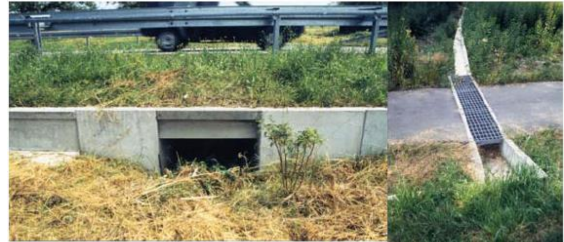
Photographie 2 : Exemples de passages à amphibiens et petite faune – source : SETRA, Routes et passages à faune, 2006.
