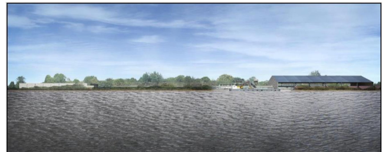
Figure 184 : Vue du projet CNR/GCA depuis la berge à l'Ouest
