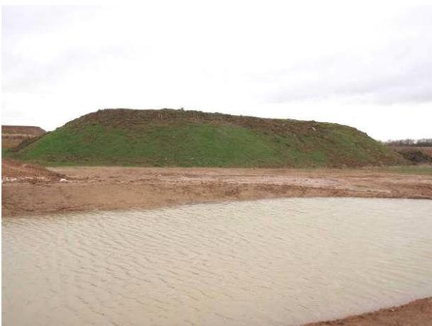
*Couverture ou ensemencement des tas de terre stockés sur chantier (source : EODD)*
