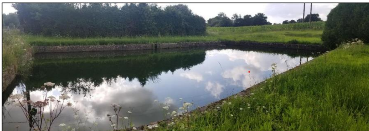
Figure n°82. Bassin empierré – Sud de la zone d'étude (photo prise sur site)
