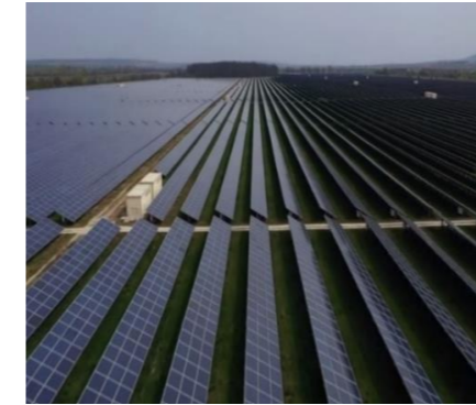
Photographie du parc photovoltaïque "Karad" - Bulgarie
