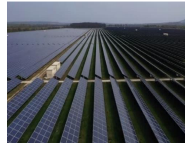
Photographie du parc photovoltaïque "Karad" - Bulgarie
