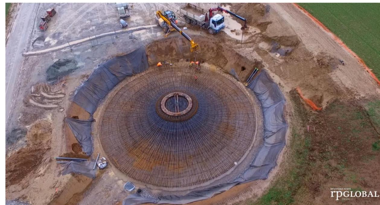
Figure 123 : Ferrailage d'une fondation
