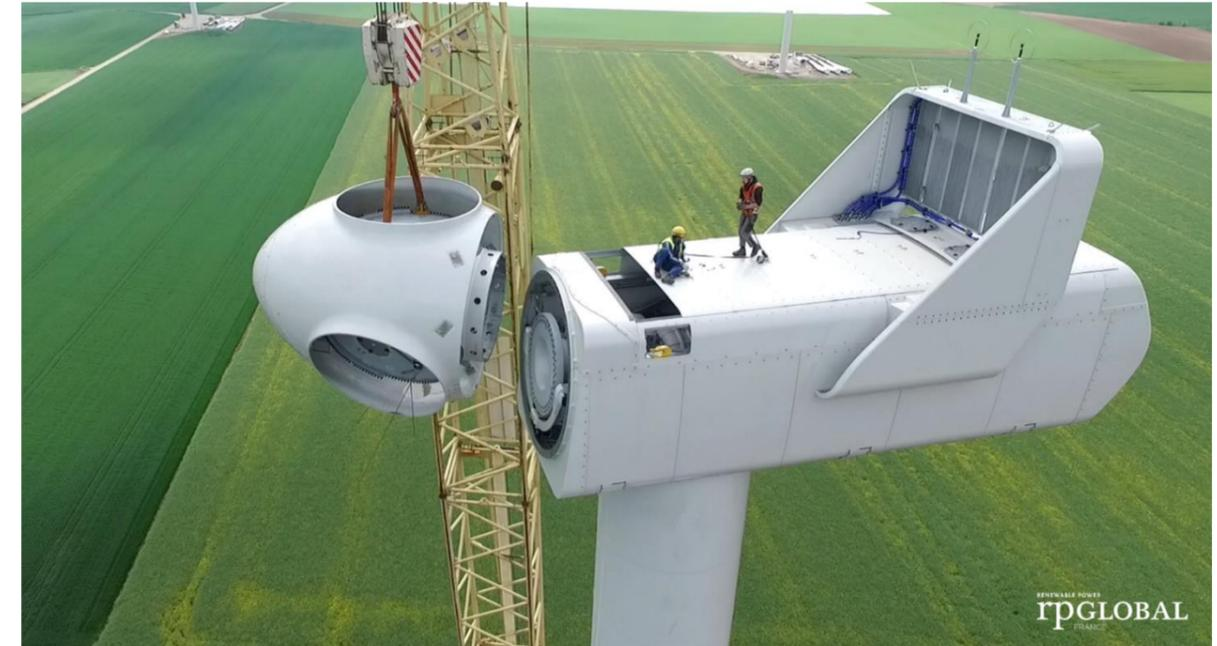
Figure 127 : Montage et assemblage du moyeu
