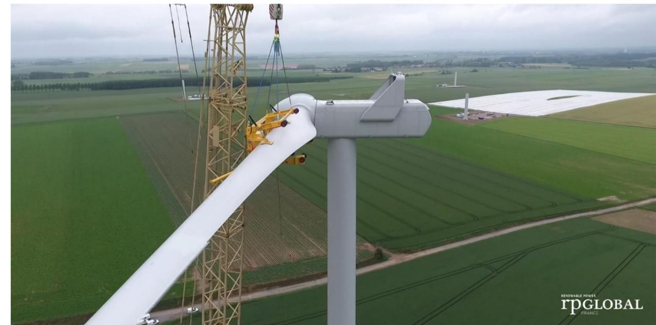
Figure 128 : Montage et assemblage des pales
