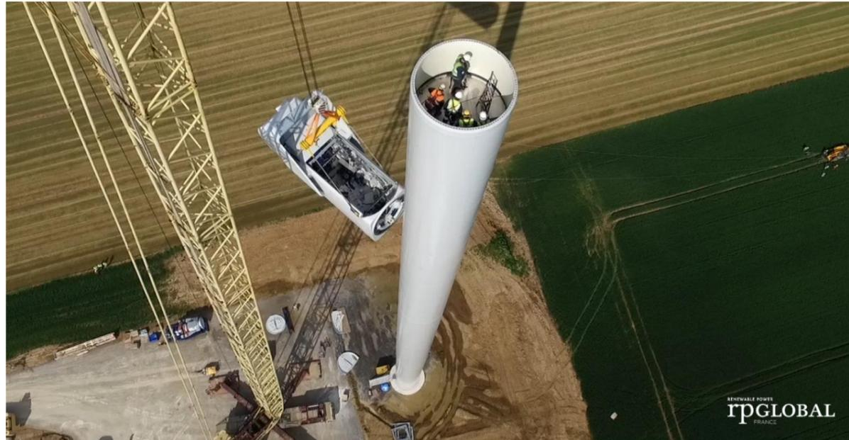
Figure 126 : Assemblage de la nacelle
