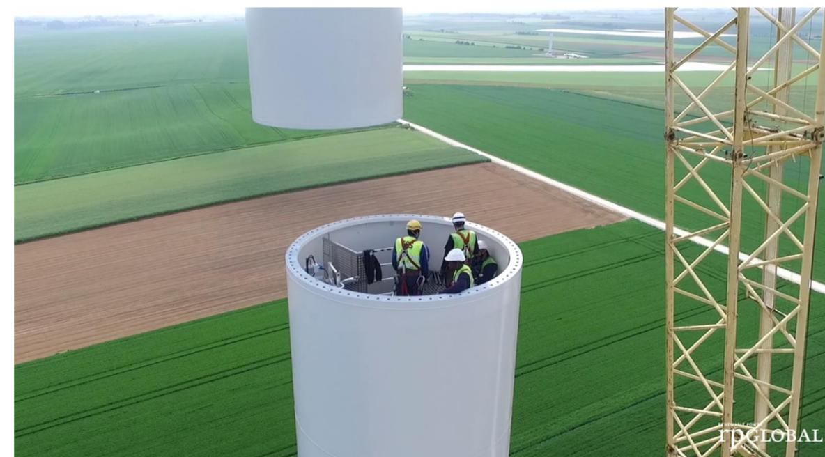
Figure 119 : Assemblage d'une section de tour
