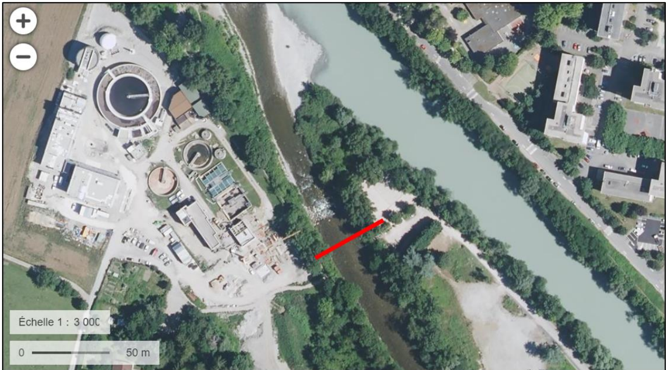
Figure 18 : Vue aérienne de la Step en chantier (juillet 2020, source : IGN).
