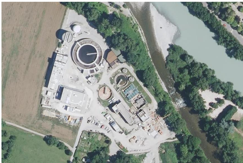
Figure 19 : Vue aérienne de la Step en chantier (juillet 2020, source : IGN).
