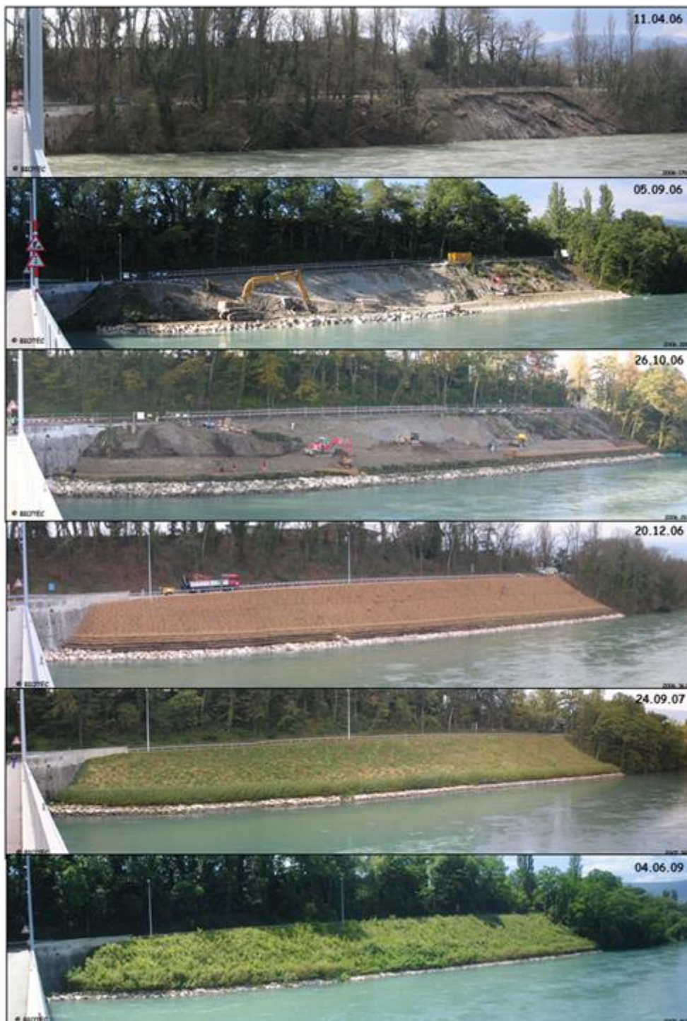
Figure 23 : Illustrations successives de la protection mixte enrochements-lits de plants et plançons-plantation mise en place en rive gauche du Rhône à Avully (Suisse) en soutènement d'une route (conception, photos et suivi des travaux : Biotec en collaboration avec GEOS
