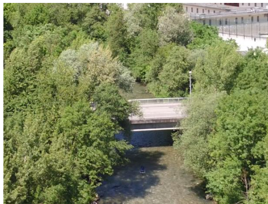
Figure 8 : Pont de Toisinges.
