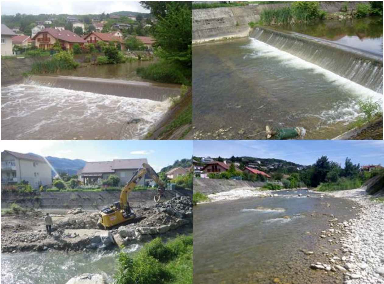
Figure 19 : Illustration d'un seuil infranchissable sur le Sierroz à Aix-Les-Bains, puis de sa démolition et la constitution d'une rampe de stabilisation du profil en long ; conception, photos et maîtrise d'œuvre Biotec
