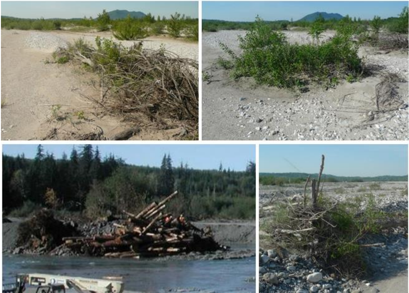
Figure 15 : Différentes vues de dépôts végétalisés ou « renforcés » par des structures souples de diversification des conditions d'écoulement : amas de souches et leurs rejets, massifs de pieux de salicacées, structures de troncs enchevêtrés et bois morts (photos Biotec).
