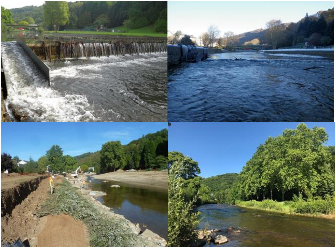
Figure 15 : Différentes vues des travaux de suppression de seuil sur la Corrèze en ville de Tulle puis de reconquête de l'espace alluvial, mise en place d'épis et re-végétalisation des berges en génie écologique (état initial en haut 2014 puis travaux en cours 2016 en bas à gauche et développement de la végétation 2020 en bas à droite), photos, conception et maîtrise d'œuvre Biotec
