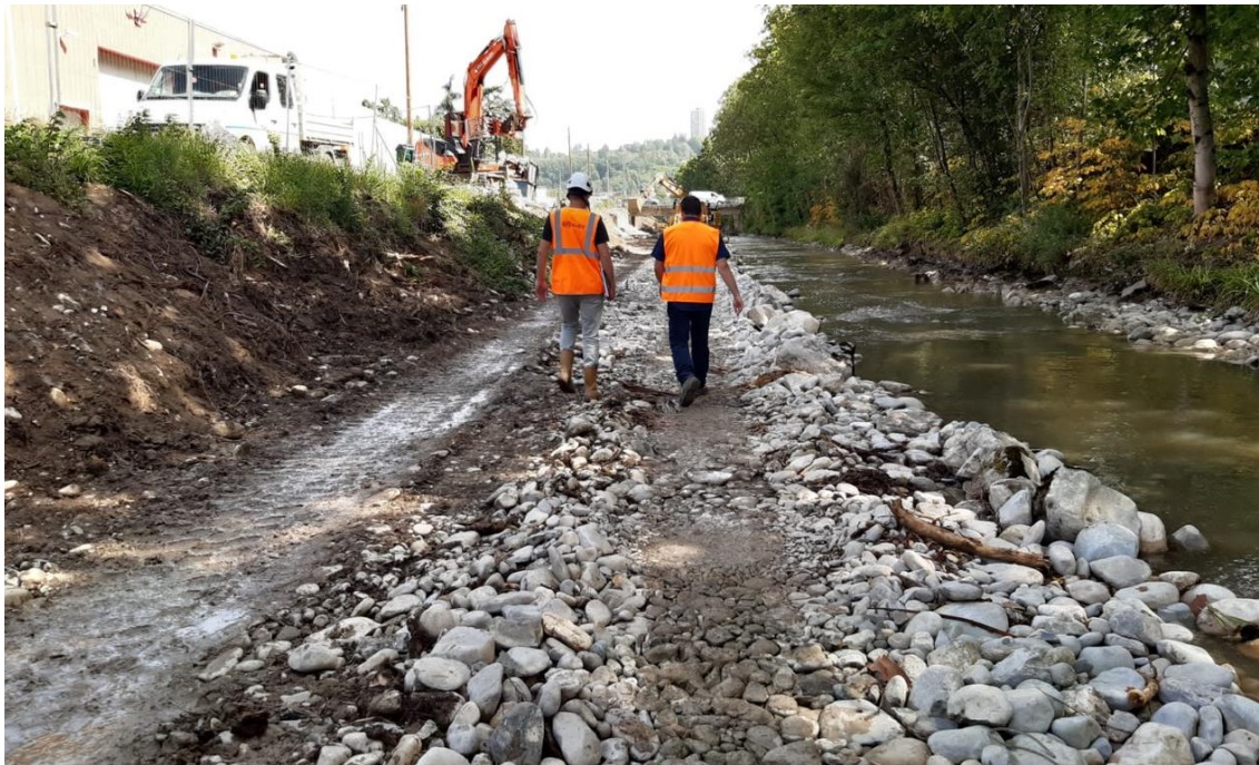
Figure 11 : Illustration d'une piste batardée
