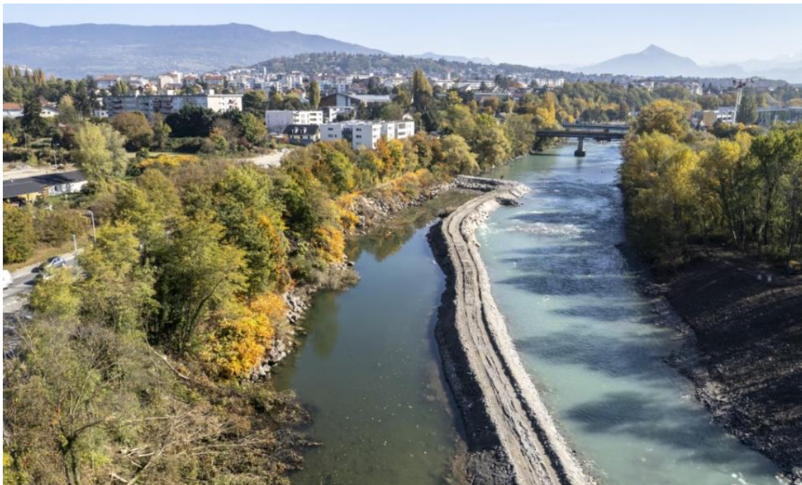
Figure 13 : Illustration d'un batardeau classique
