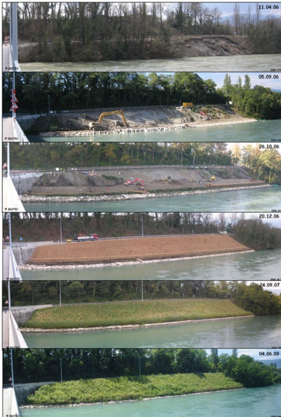
Illustrations successives de la protection mixte enrochements-lits de plants et plançons-plantation mise en place en rive gauche du Rhône à Avully (Suisse) en soutènement d'une route (conception, photos et suivi des travaux : Biotec en collaboration avec GEOS
