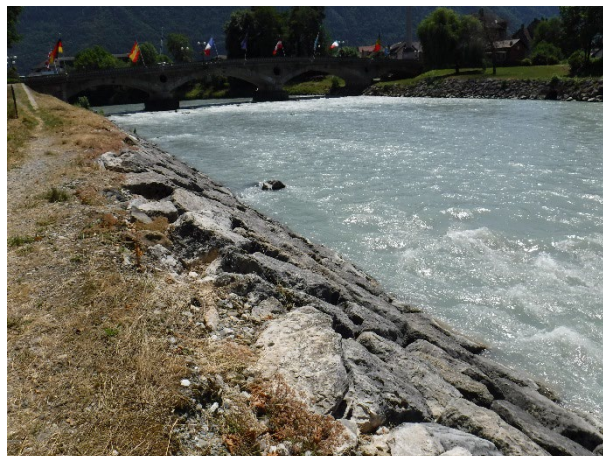
Digues enrochées au niveau de la rive gauche et de la rive droite, plus particulièrement au niveau du Pont de l'Europe
