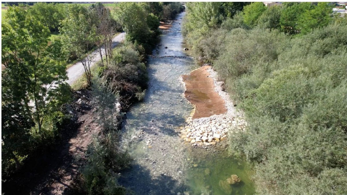
Figure 10 : Aperçu d'une banquette et d'un épî (vue vers l'amont)
