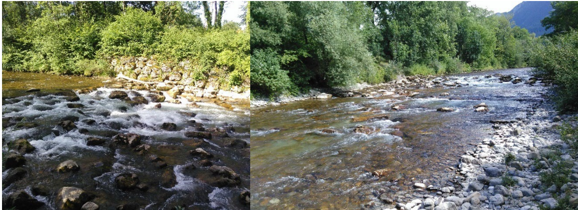
Figure 20 : Seuil en enrochement en amont de la confluence avec l'Arve
