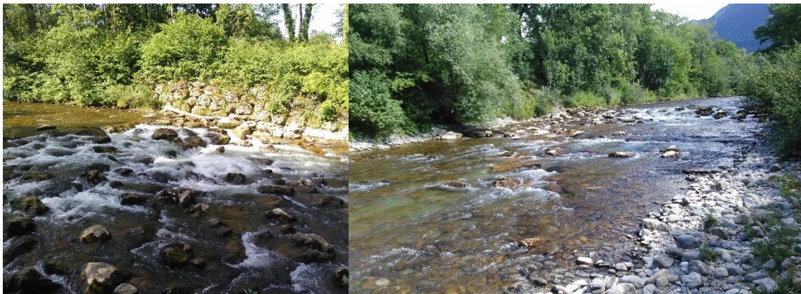
Figure 5 : Seuil en enrochement en amont de la confluence avec l'Arve
