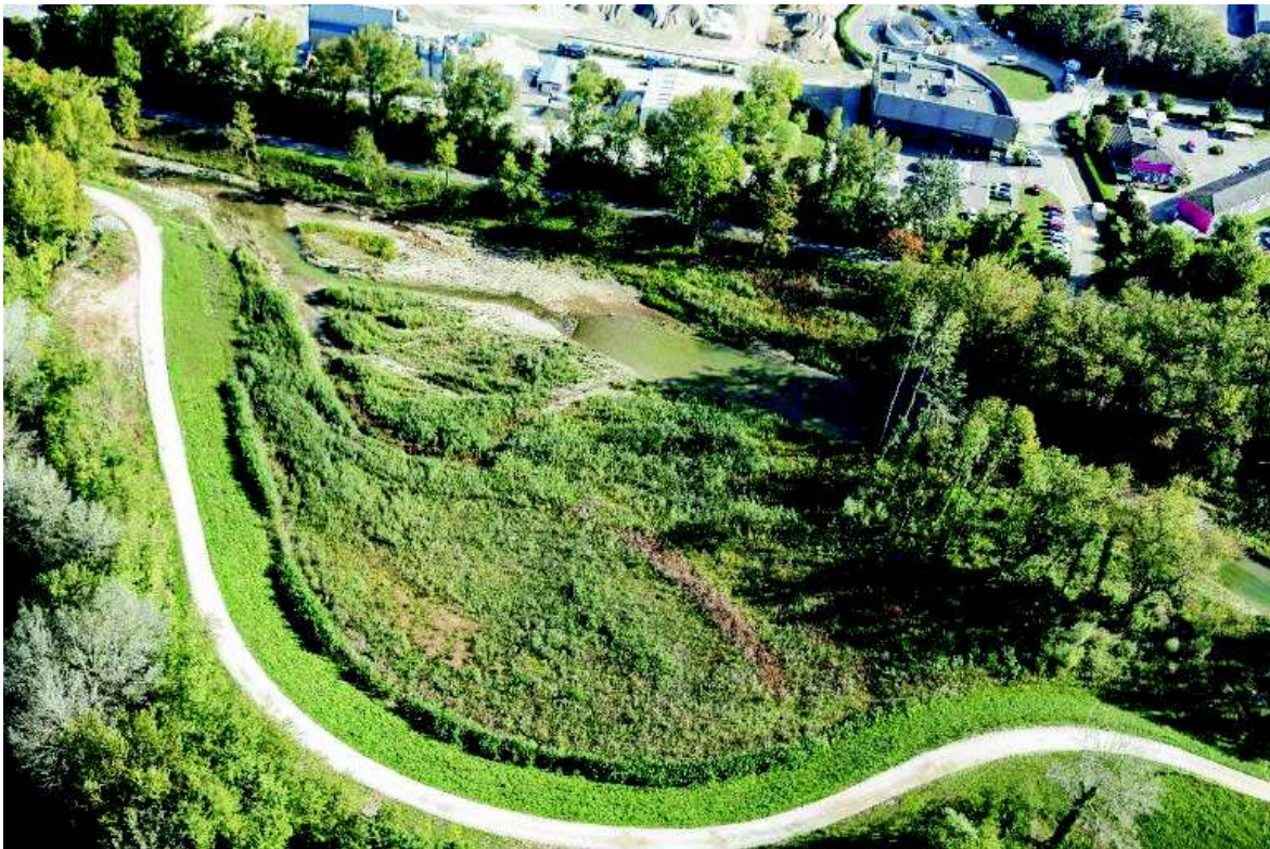
Figure 180 : Exemple de déport de l'ouvrage : la digue aval à Chambéry (CISALB)
