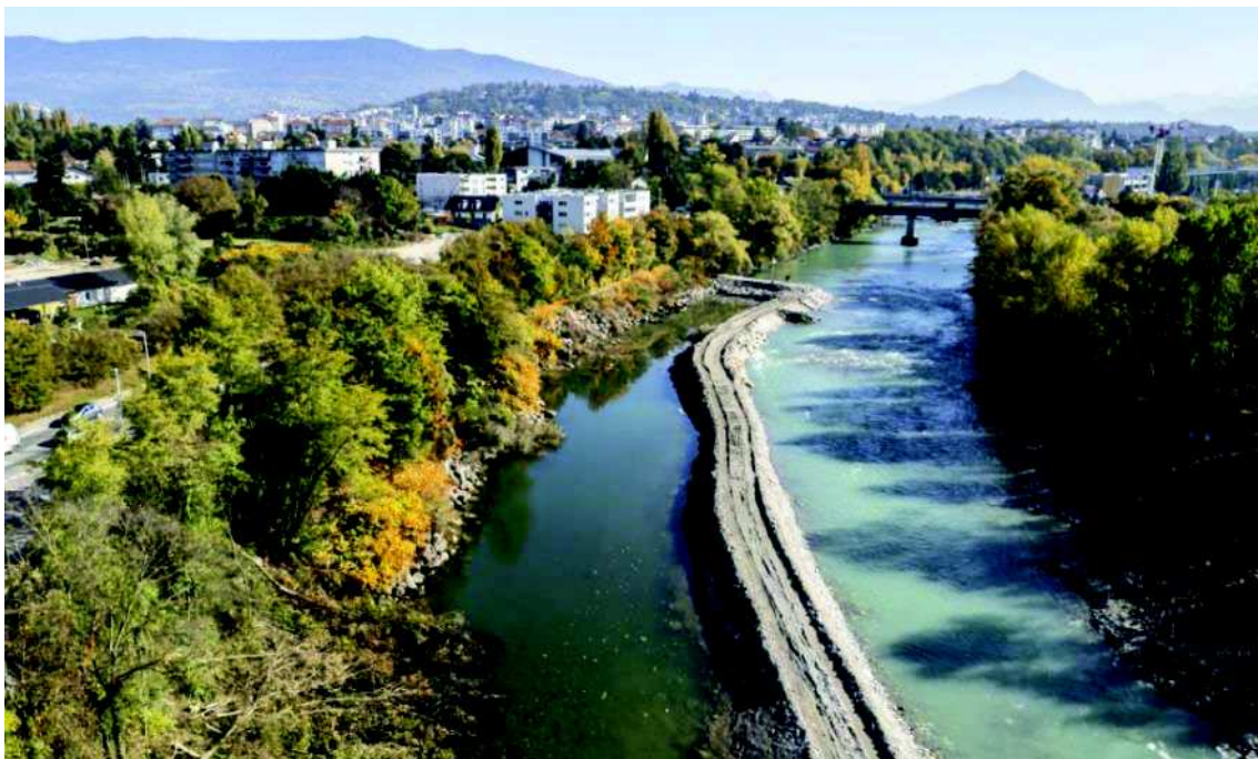
Figure 76 : Illustration d'un batardeau classique
