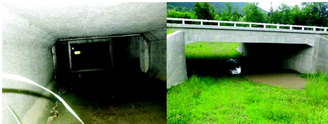
Figure 132 : De gauche à droite, castoroduc et passage sous la D19
