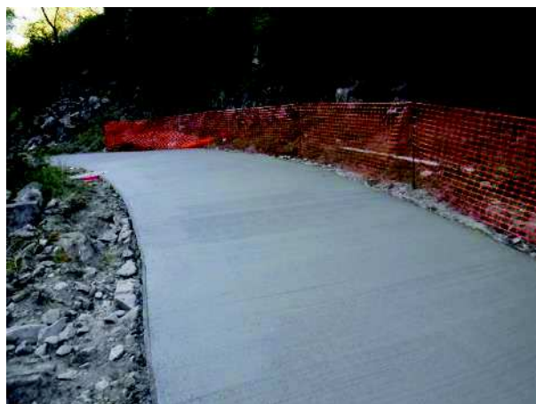
Figure 169 : Exemple d'un balisage le long d'une voirie créée (Mosaïque Environnement)
