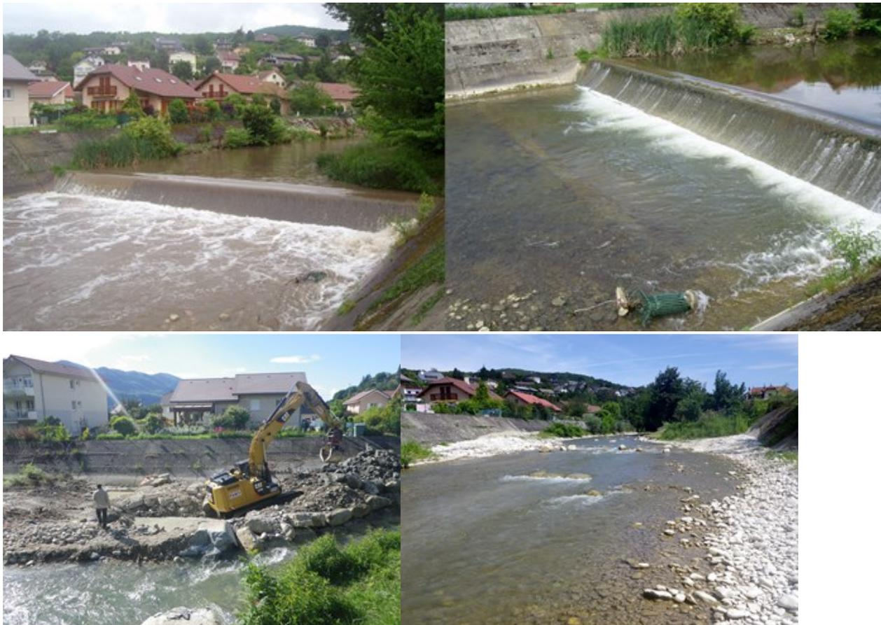
**Illustration d'un seuil infranchissable sur le Sierroz à Aix-Les-Bains, puis de sa démolition et la constitution d'une rampe de stabilisation du profil en long ; conception, photos et maîtrise d'œuvre Biotec**
