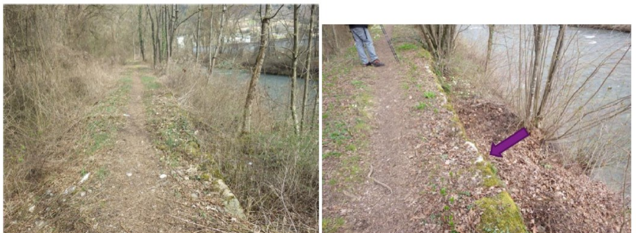
Figure 53 : Digue de la STEP (photos de la digue - CNR)
