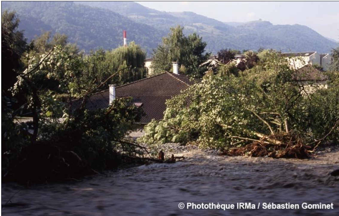
Figure 80 : Rupture de la digue en rive gauche
