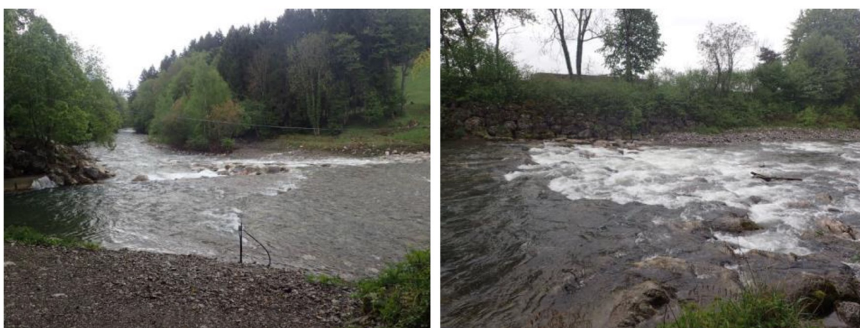
Figure 54 : Seuil Métral vue vers l'aval (à gauche) et seuil amont à la confluence vue vers l'aval (à droite) – photos CNR
