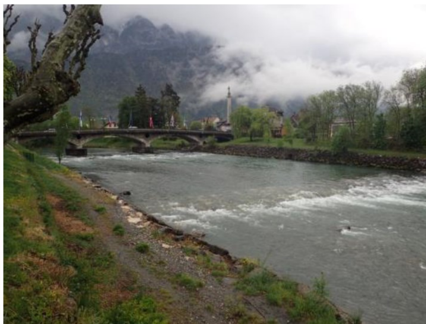
Figure 55 : Seuil aval au pont de l'Europe, vue vers l'amont - CNR
