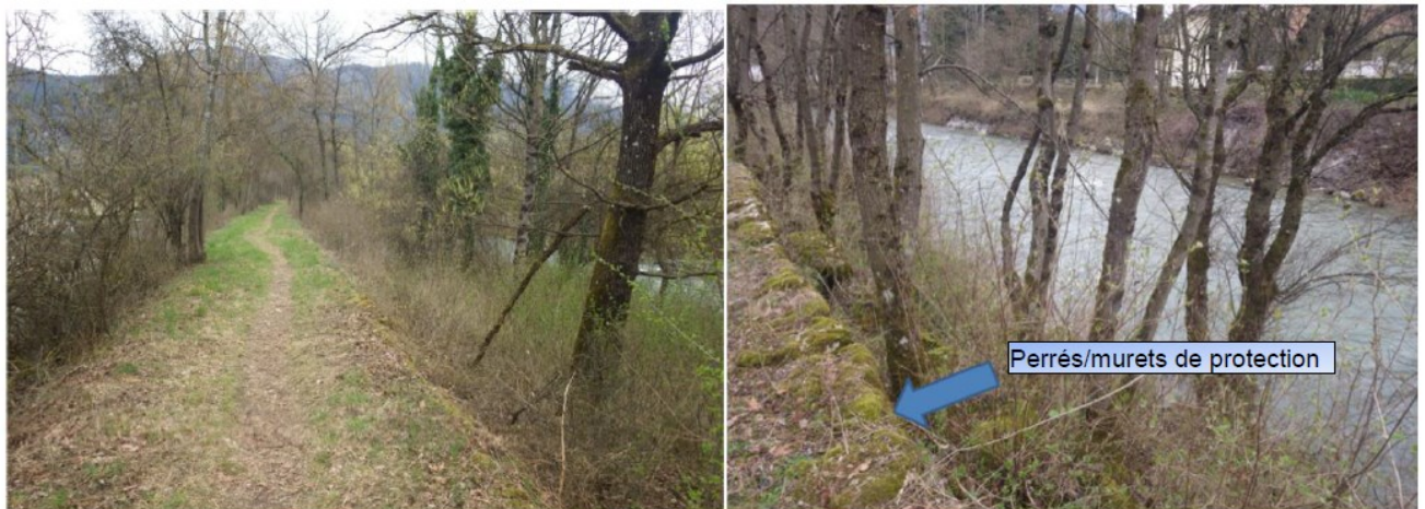
Figure 51 : Digue de Toisinges (photos de la digue - CNR)
