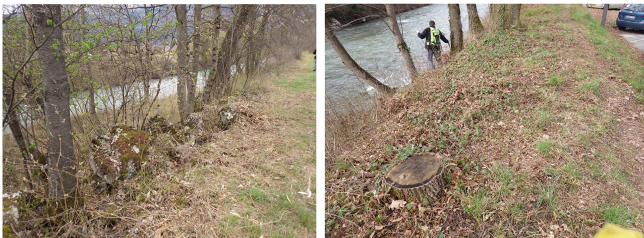
Photo n°6 et 7 – Végétation arborée en crête de digue et présences de souches
