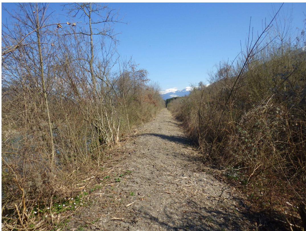
Photo n°1 - Profil type de la digue
