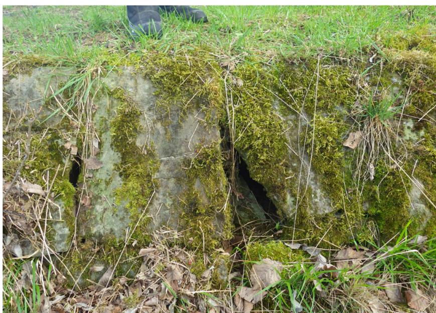
Photos n°6 : Apparition de mini-cavités à travers la carapace de protection
