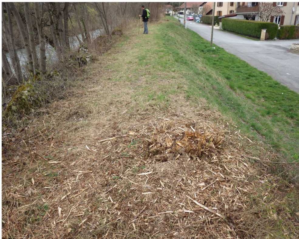
Photo n°1 – Profil type de la digue
