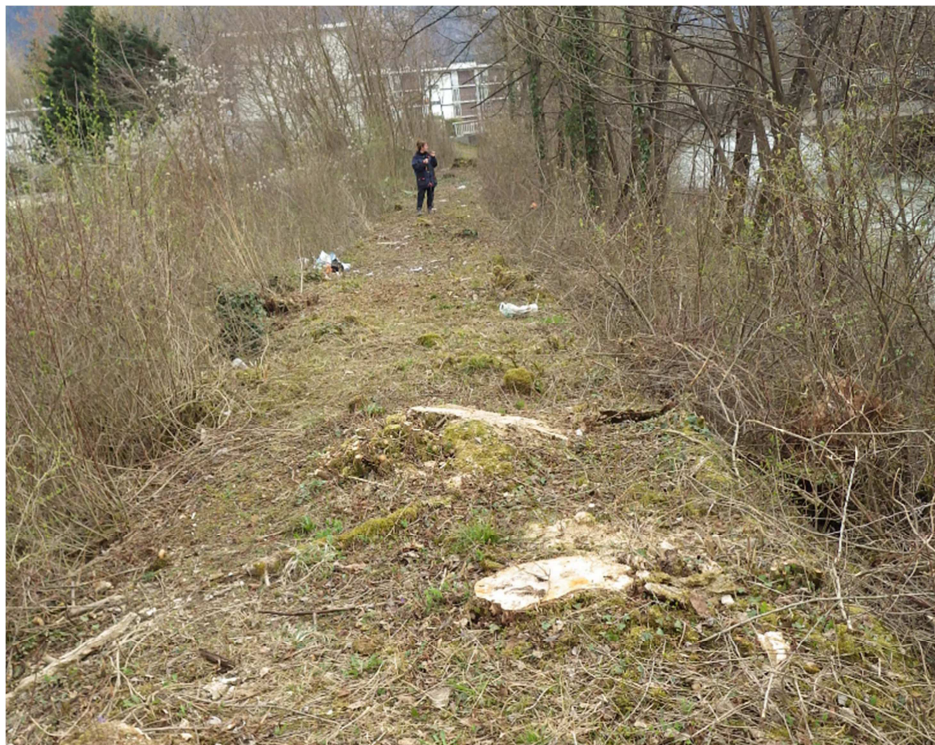
Photo n°8 – densité importante de souches en crête
