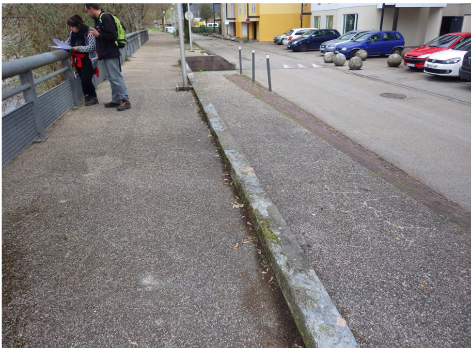
Photo n°5 – Rampe d'accès handicapé
