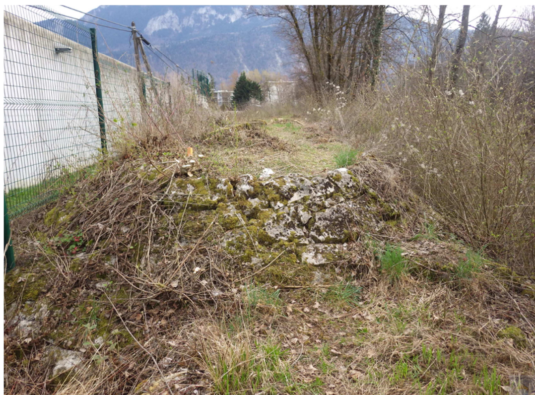
Photo n°1 - Transition digue / merlon au niveau de la prison
