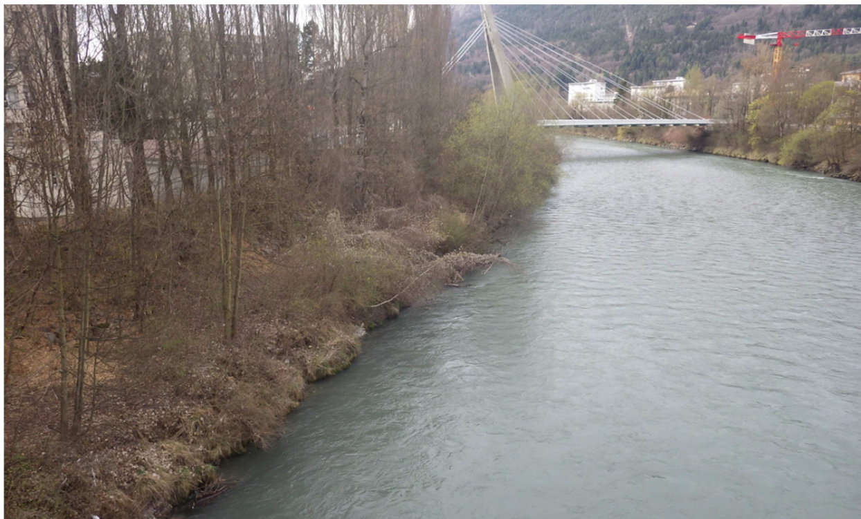
Photo n°3 : Absence de phénomènes d'affouillement marqués du pied de l'ouvrage
