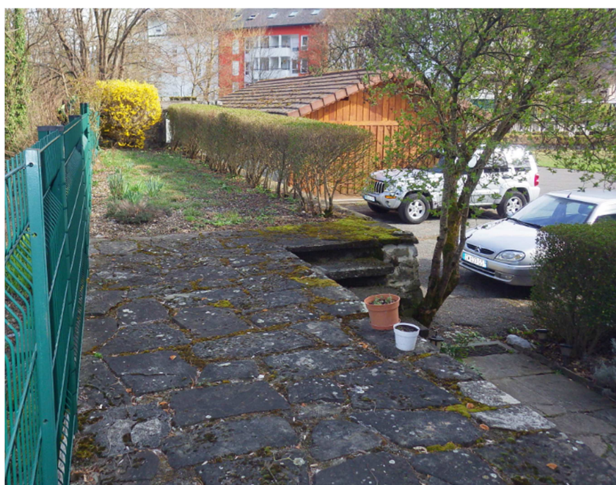
Photo n°6 – Escalier dans talus aval
