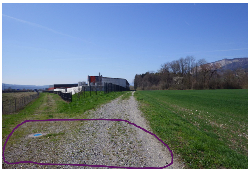
Photo n°3 : présence d'un point bas à l'extrémité amont de l'ouvrage
