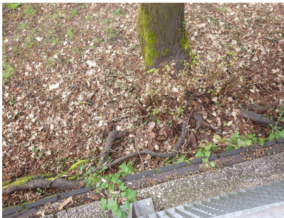
Photo n°3 – Talus amont plateforme – végétation arborée en pied/racines vagabondes
