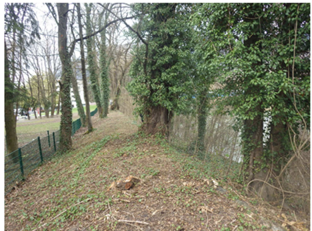
Photo n°6 et 7 – Muret présent en pied de talus aval et végétation arborée épars sur le talus aval
