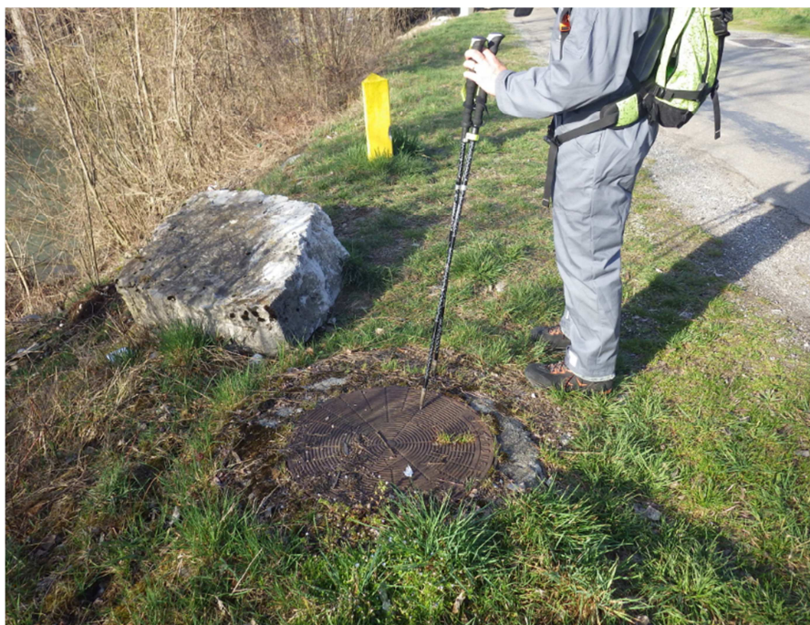
Photo n°3 : Borne réseau gaz (traversant ?)
