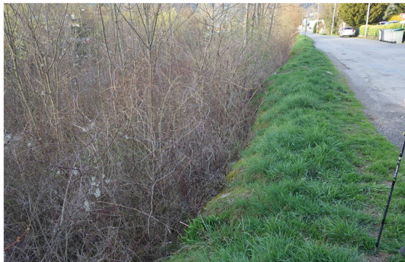
Photo n°2 : Absence d'entretien du talus côté rivière
