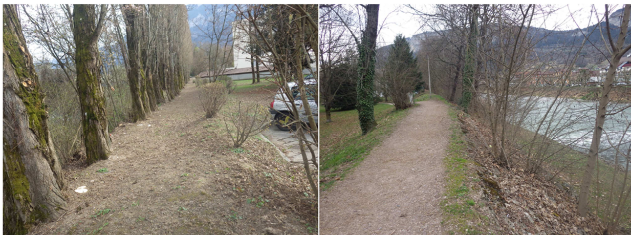
Photos n°1 et 2 –Profil type de la digue (aval à gauche, amont à droite)
