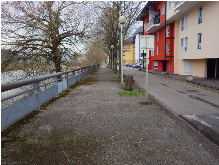
Photo n°1 – Profil type de la digue
