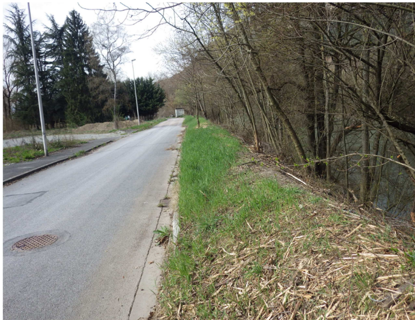
Photo n°1 : Profil type de digue
