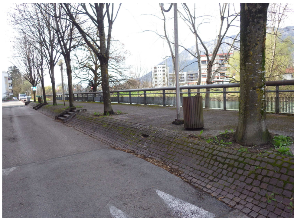
Photo n°2 – Talus aval plateforme – revêtement de petits éléments maçonnés
