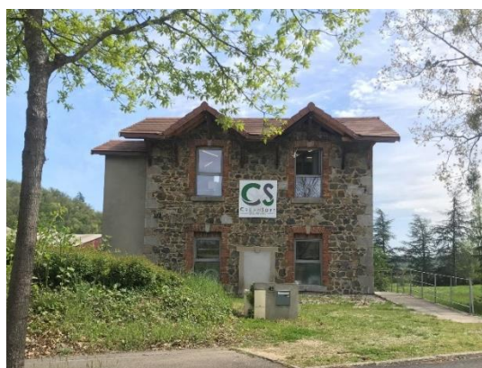
Enseigne sur un bâtiment protégé par le PLU (ZA de Sacuny)
