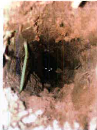
Sondage 17 (présence d'eau)
