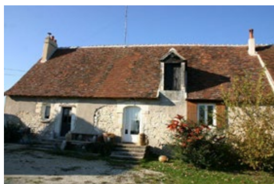
Figure 25 : Logement de la ferme de Montbrioux, Azay-le-Ferron (© Région Centre-Val de Loire, Inventaire général © Parc naturel régional de la Brenne)
