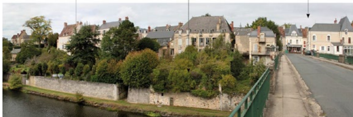
L'entrée sud de la ville de Saint-Gaultier présente bien le contexte paysager : une façade uniforme, composée d'éléments remarquables à caractère patrimonial, dont une grande partie est vacante.
